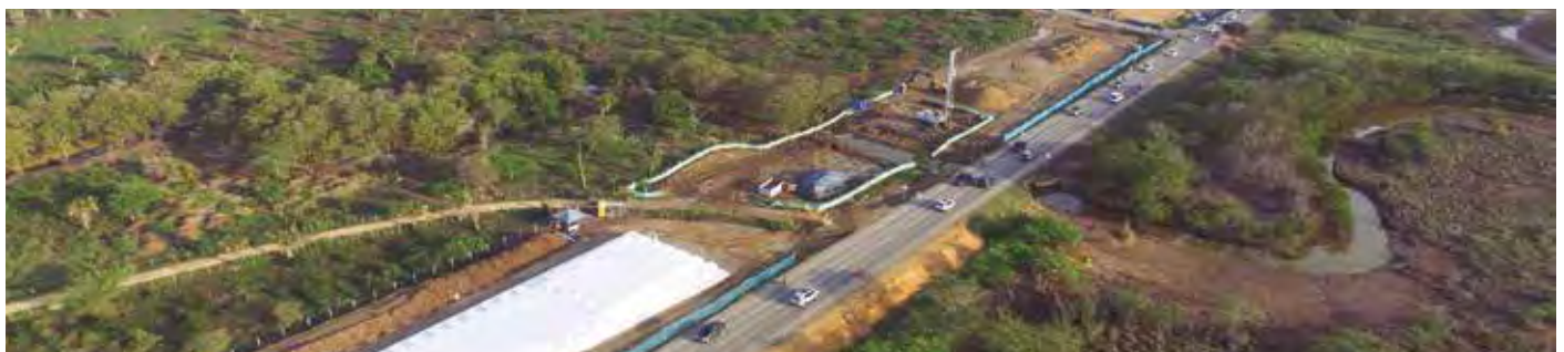
Construcción de la Circunvalar de la Prosperidad. Cartagena - Barranquilla
