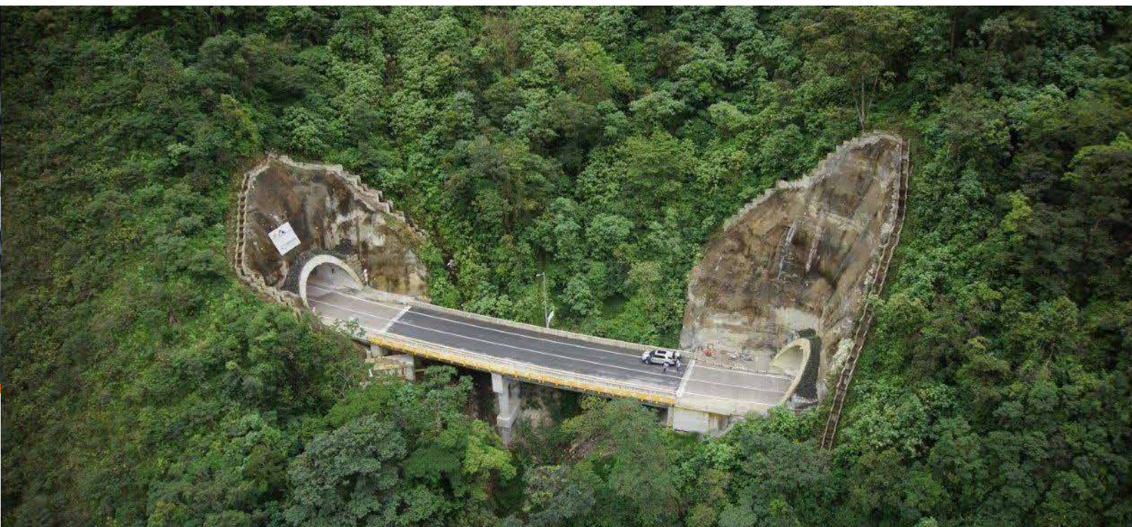
Túneles de la Autopista Bogotá - Villavicencio
