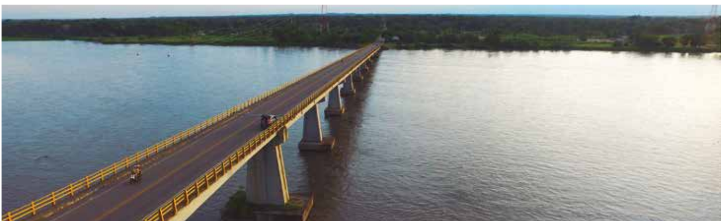
Puente Guillermo Gaviria sobre el río Magdalena. Concesión Bucaramanga - Barranca - Yondó.
