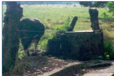
CAJA DE INSPECCIÓN
