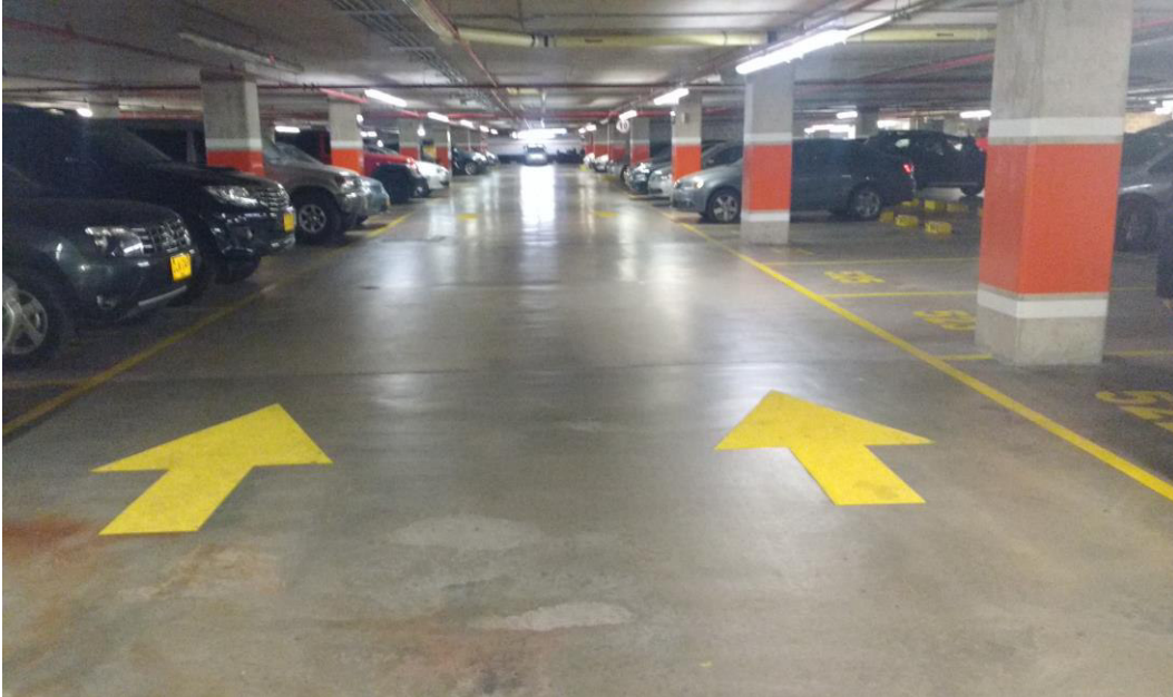
Imagen N°4: Demarcación y señalización zonas de circulación vehículos
