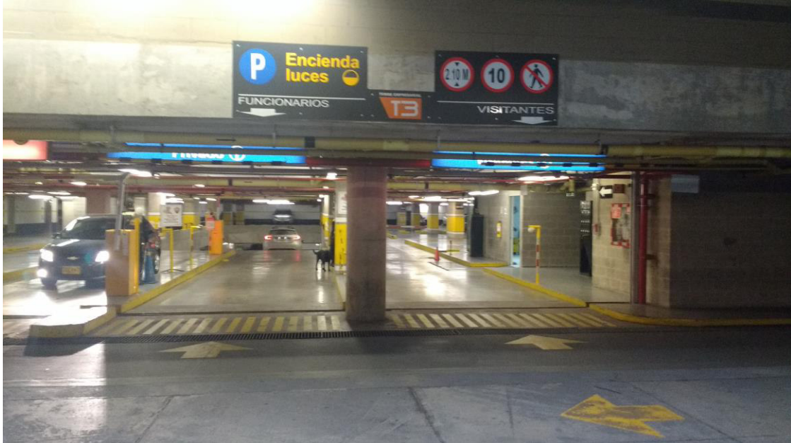
Imagen N°7: Evidencia señalización y demarcación entrada y salida parqueaderos
