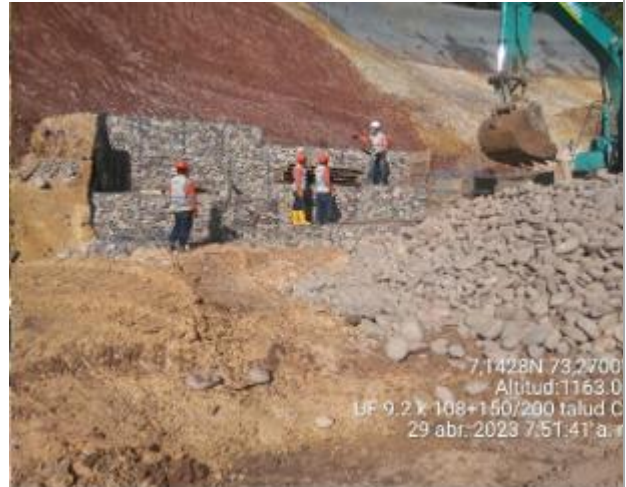
Foto 13. UF9 – Taludes PK108+150
