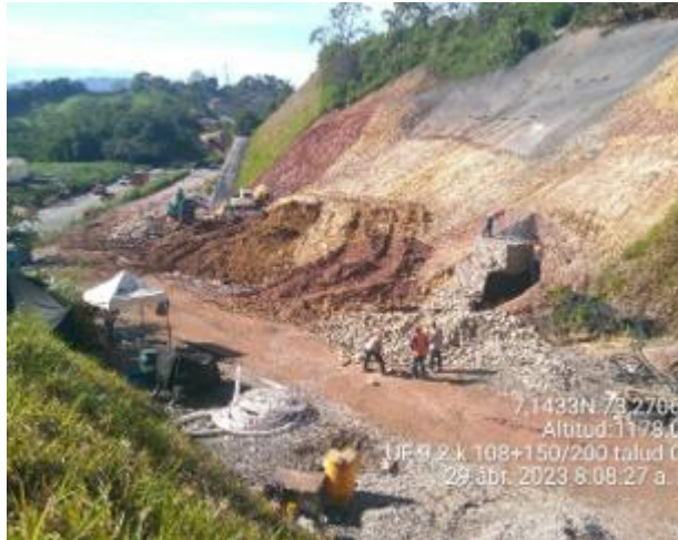
Foto 12. UF9 – Taludes PK108+150
