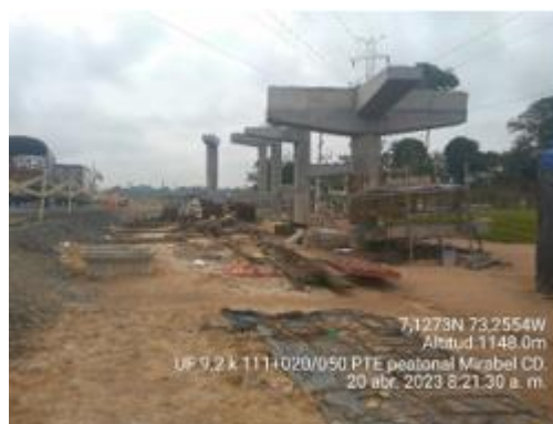
Foto 7. UF9 – Puente peatonal sector Mirabel PK111+400
