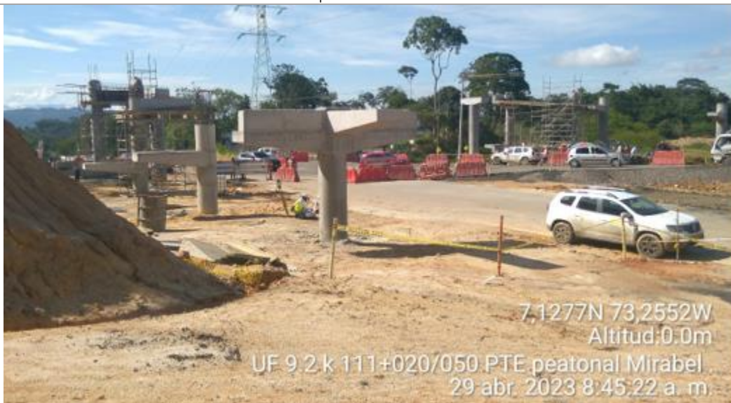
Foto 8. UF9 – Puente peatonal sector Mirabel PK111+400
