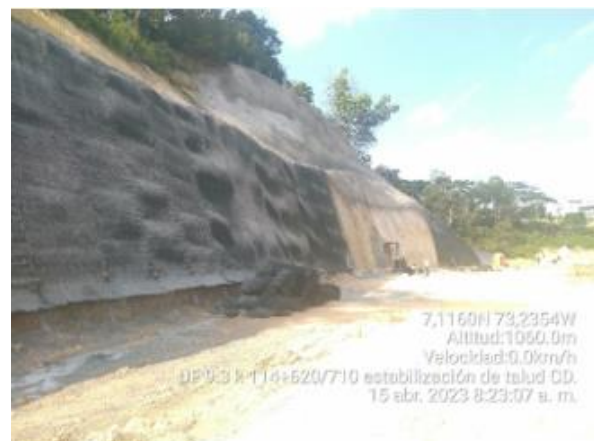
Foto 15. UF9 – Taludes PK114+640
