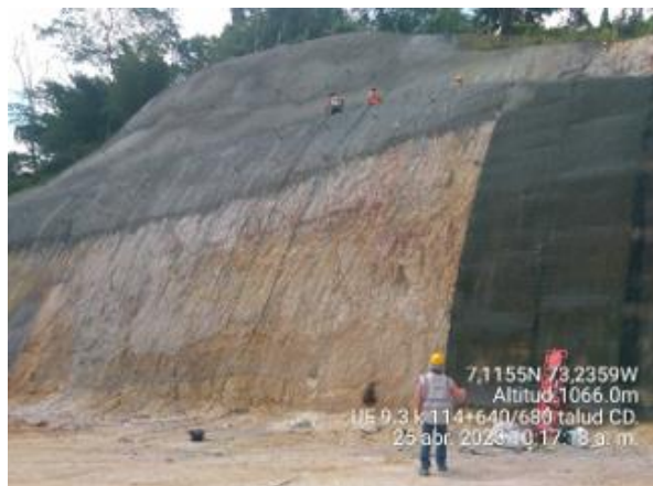
Foto 14. UF9 – Taludes PK114+640
