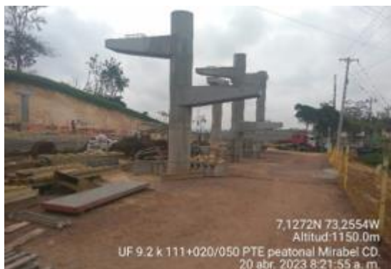
Foto 6. UF9 – Puente peatonal sector Mirabel PK111+400
