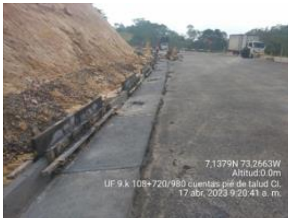
Foto 18. UF9 – Cunetas K108+720
