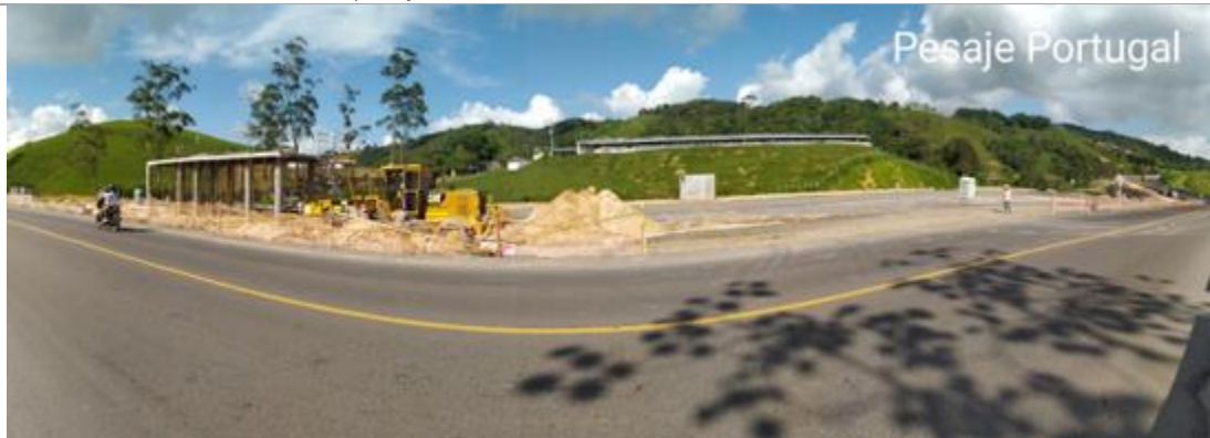
Foto 11. UF9 – Edificio estación de pesaje K106+452
