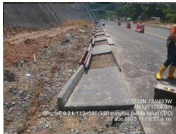
Foto 19. UF9 – Cunetas K112+230
