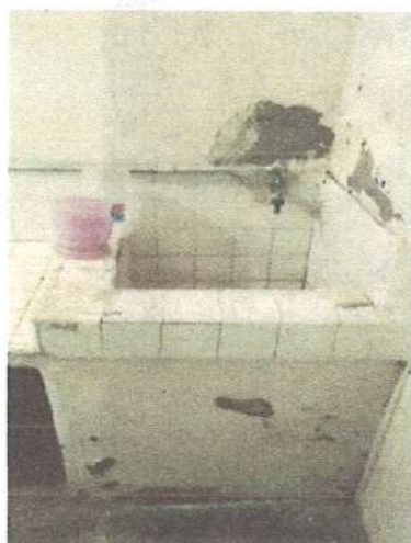
C1: CONSTRUCCIÓN 1- TANQUE
