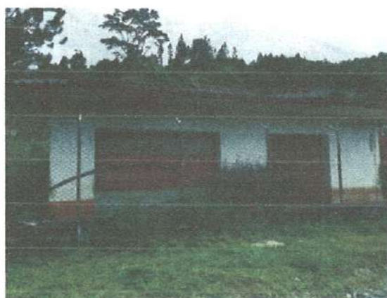
C1: CONSTRUCCIÓN 1- FACHADA
