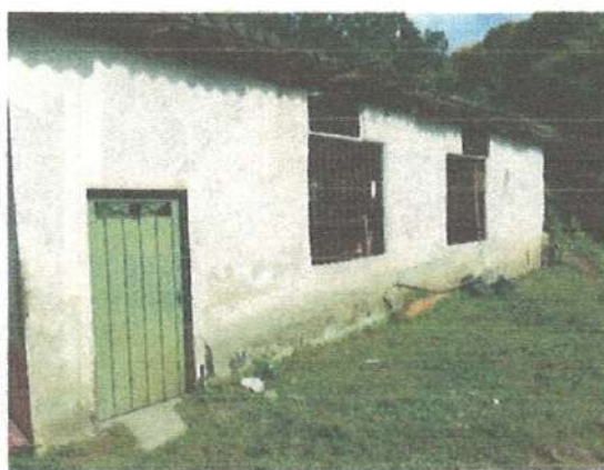
C1: CONSTRUCCIÓN 1- ZONA LATERAL Y ACCESO A LA CONSTRUCCIÓN
