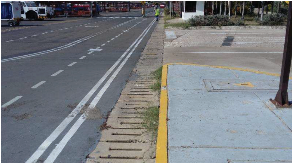
Ilustración 59: Canaleta a demoler
