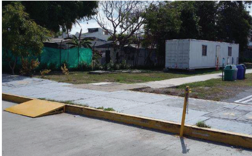
Ilustración 60: Vallado perimetral a demoler
