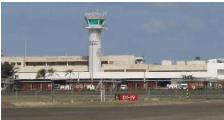
Ilustración 12: Vista de la Torre de Control
