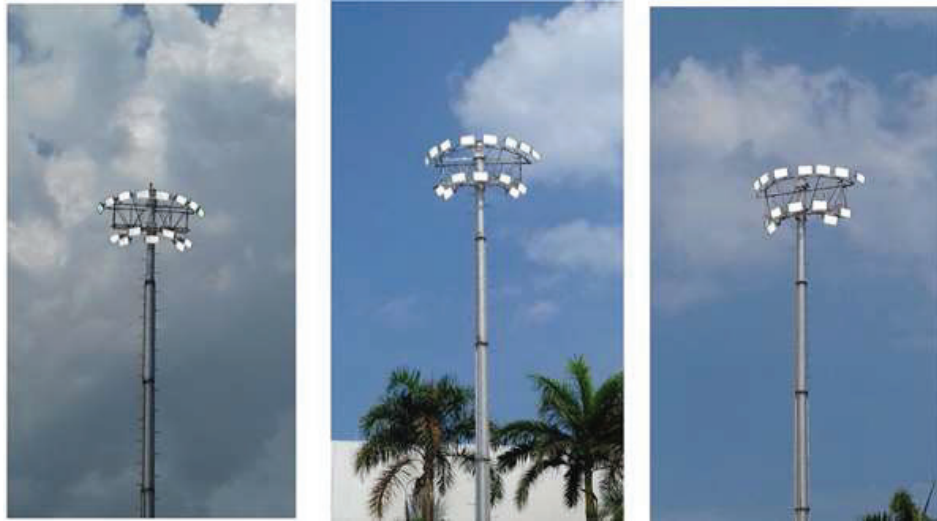
Ilustración 58: Torres de iluminación a desmontar
