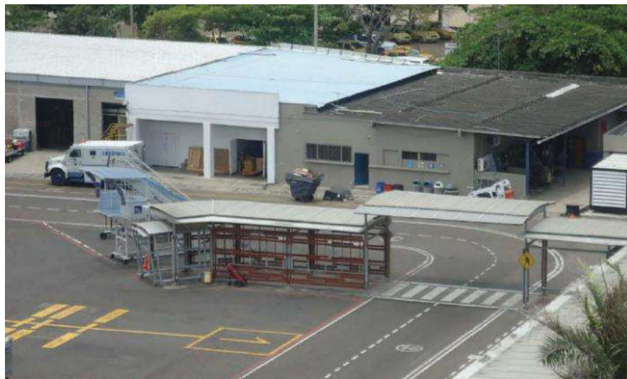
Ilustración 57: Marquesinas a desmontar
