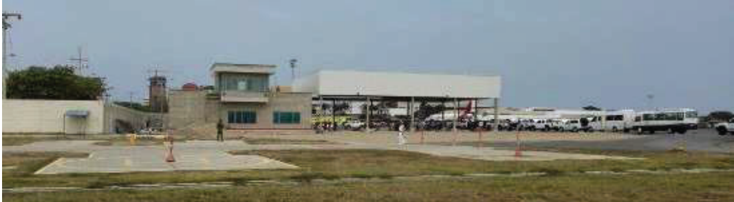
Ilustración 14: Vista del edificio SEI
