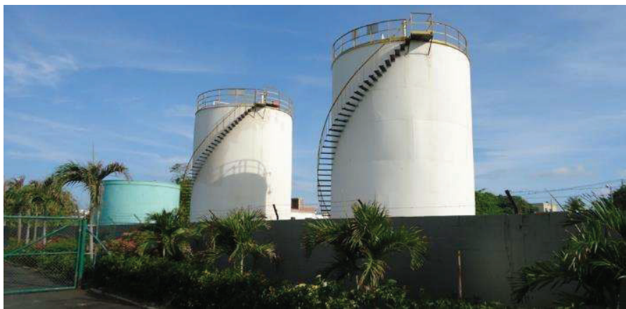
Ilustración 18: Vista de los depósitos de combustible al norte del Terminal
