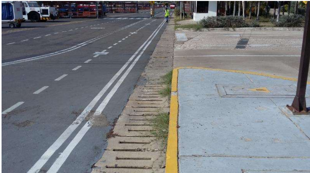
Ilustración 59: Canaleta a demoler
