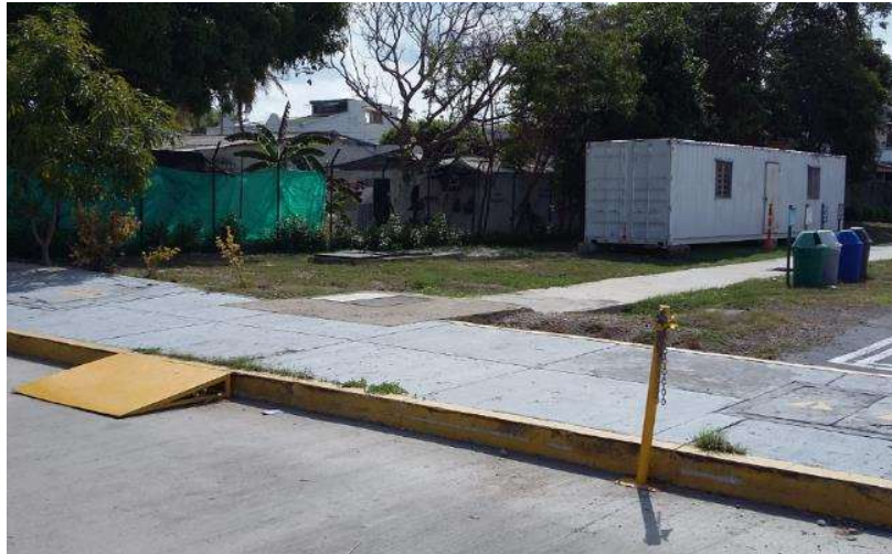
Ilustración 60: Vallado perimetral a demoler
