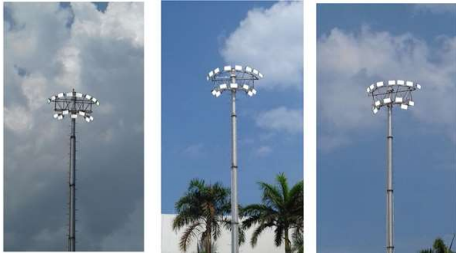
Ilustración 58: Torres de iluminación a desmontar
