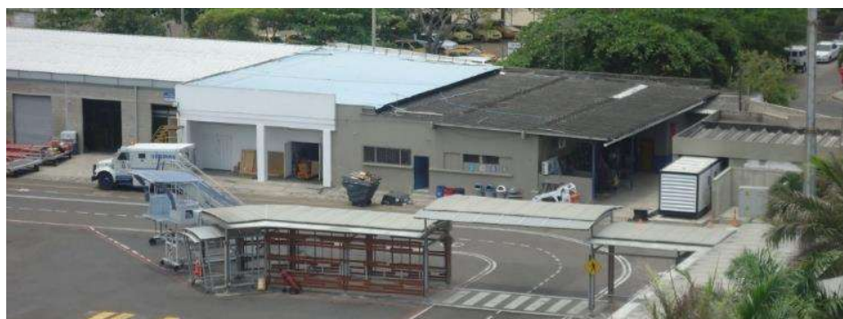
Ilustración 25: vista de las zonas de mantenimiento de vehículos-Zona Oeste
