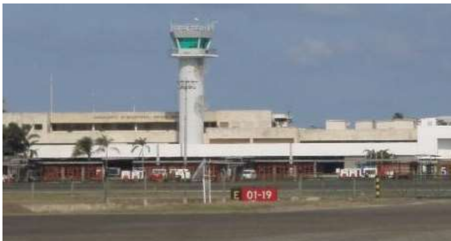
Ilustración 12: Vista de la Torre de Control
