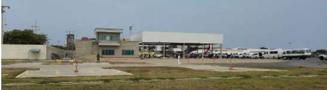
Ilustración 14: Vista del edificio SEI
