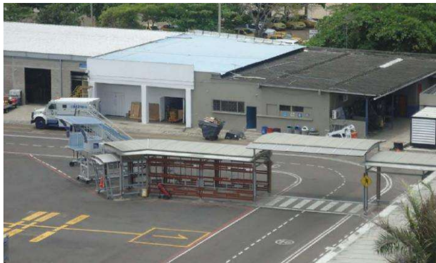
Ilustración 57: Marquesinas a desmontar
