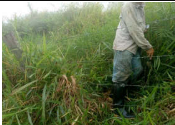
Construcción B1 Cerca
