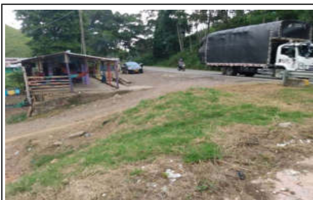
Vía nacional 066 sentido a Barrancabermeja
