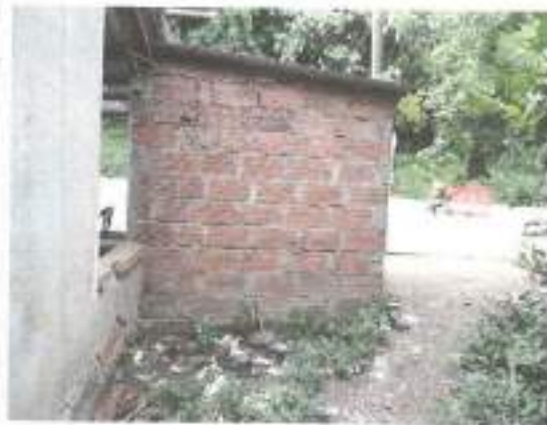
C1: CONSTRUCCION 1- FACHADA
