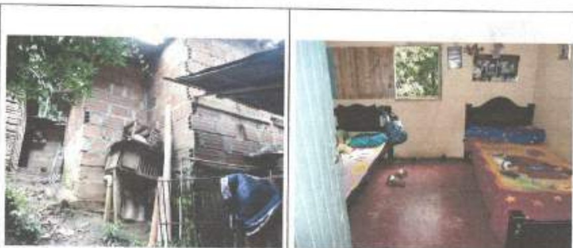
C4: CONSTRUCCION 4- FACHADA
