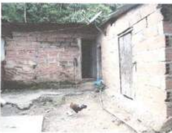
C2: CONSTRUCCION 2 – FACHADA
