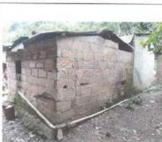
C3: CONSTRUCCION 3- FACHADA
