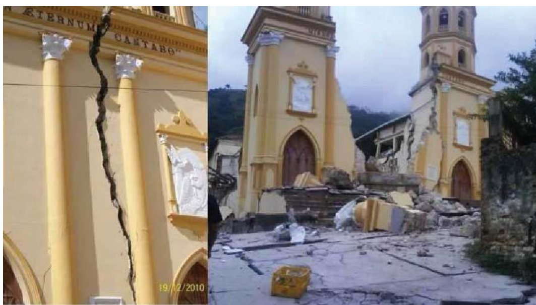
Figura 7-3. Ruinas en Gramalote debidas al movimiento en masa que se presentó causado por La Niña 2010–2011
