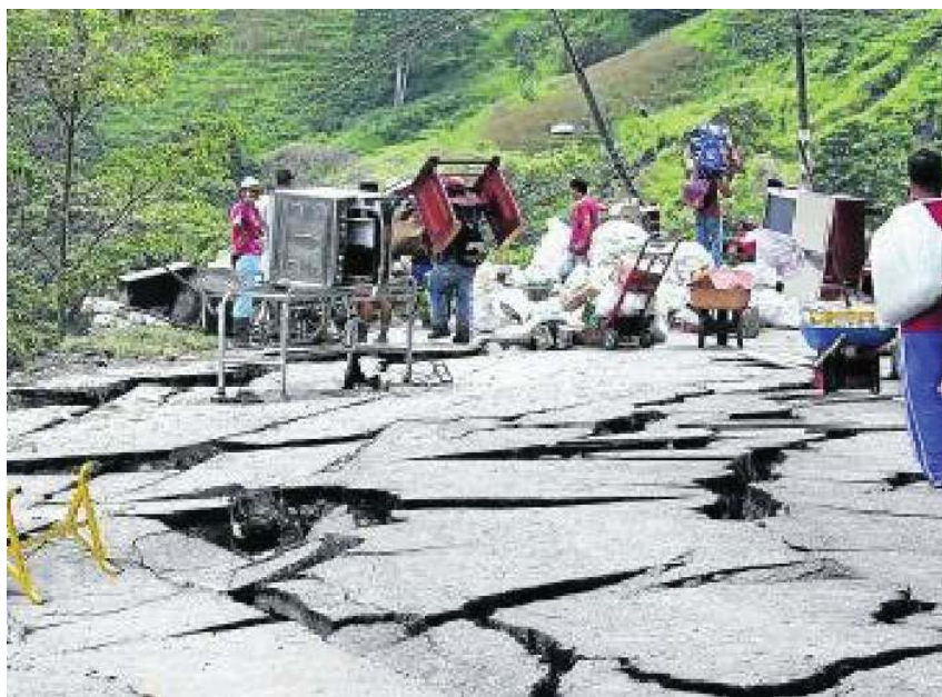
Figura 7-2. Ruinas en Gramalote debidas al movimiento en masa que se presentó causado por La Niña 2010–2011 [330]
