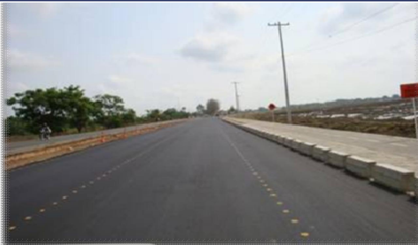
Construcción Segunda Calzada Te Aeropuerto – Retiro de Los Indios
