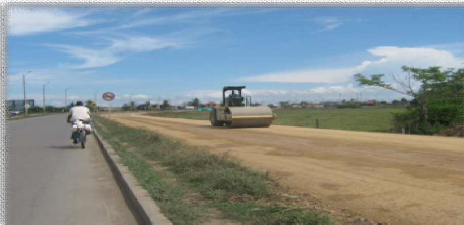
Compactación Base Granular K1+300-K1+350
