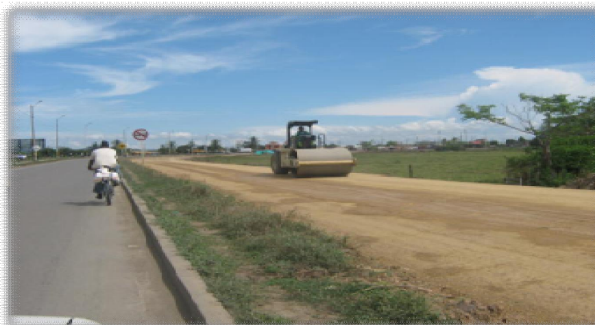
Compactación Base Granular K1+300-K1+350
