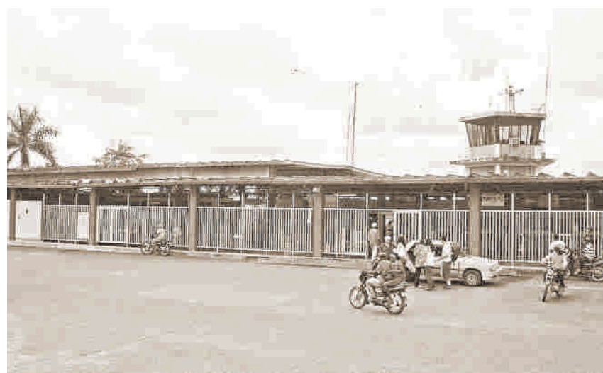
Este era el antiguo aeropuerto El Caraño, que fue demolido para hacer el nuevo.
