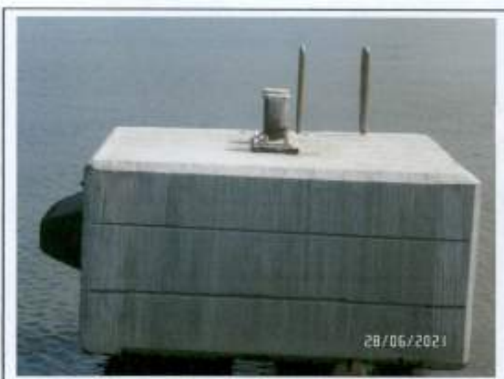
Fotos 13-14. Estado actual y características de las dos pías de atraque
