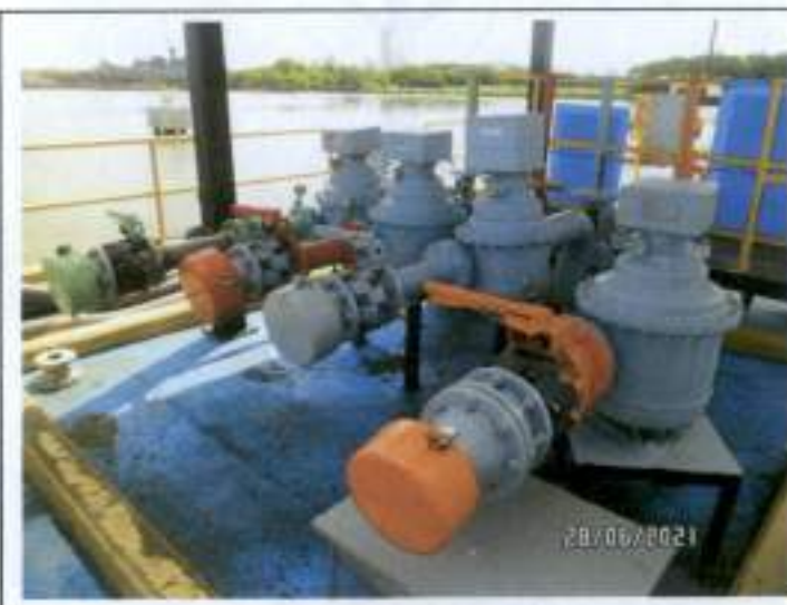
Fotos 23-24. Equipos accesorios integrales del sistema de transferencia de combustibles, conformados por contadores de flujo y filtros.
