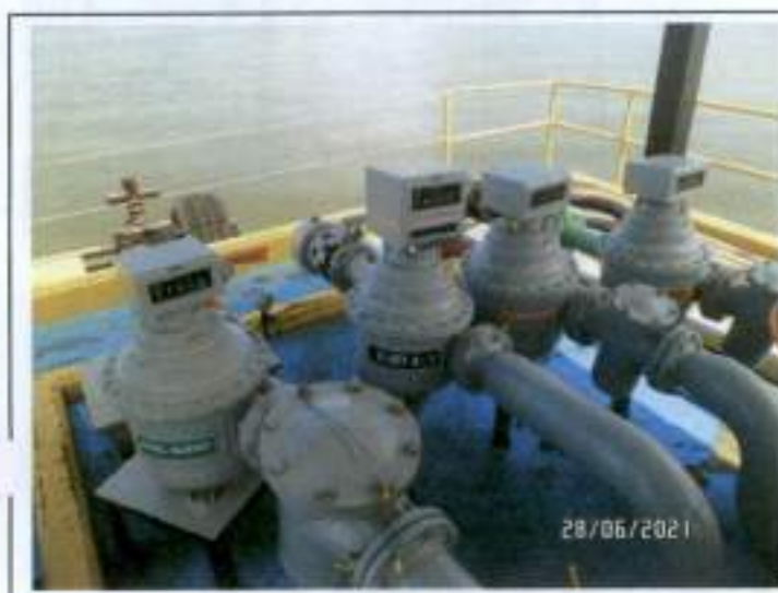
Fotos 23-24. Equipos accesorios integrales del sistema de transferencia de combustibles, conformados por contadores de flujo y filtros.
