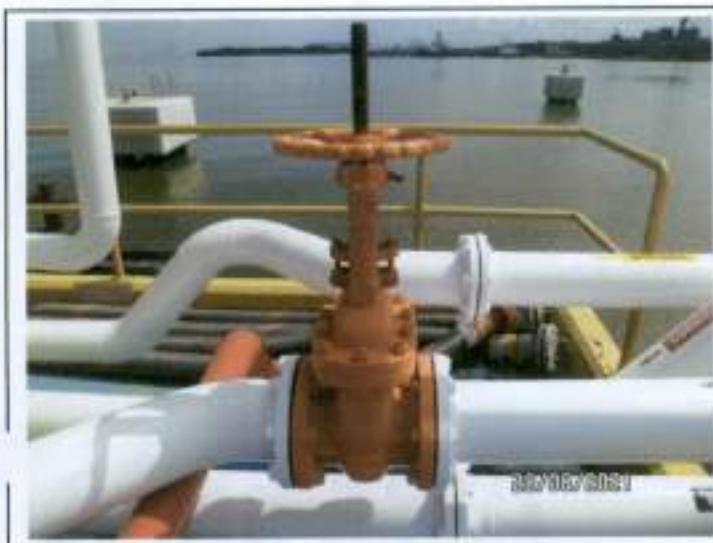
Fotos 21-22. Sistema de tuberías de transferencia instaladas a lo largo de la pasarela, en
