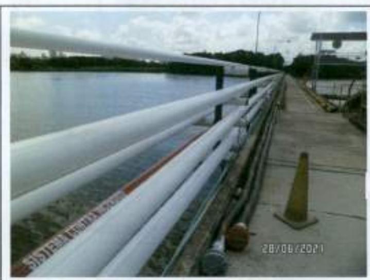
Fotos 19-20. Sistema de tuberías de transferencia instaladas a lo largo de la pasarela, en áreas bienes de uso público, concesionadas por la ANI.
