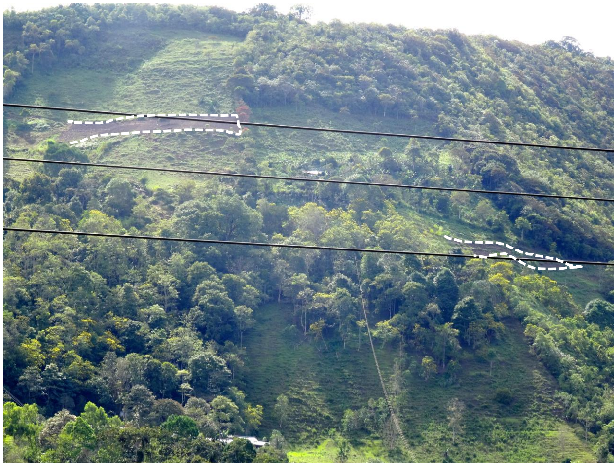
Figura 32. Dos escarpes, resaltados con líneas blancas punteadas, son observados cerca de la parte superior de la montaña, hacia el costado en que la salida del túnel El Trigo está planeada, antes de cruzar el Río San Francisco a través del Puente Rio San Francisco Alto y entrar al Túnel La Cumbre. La fotografía mirando hacia el oriente.
