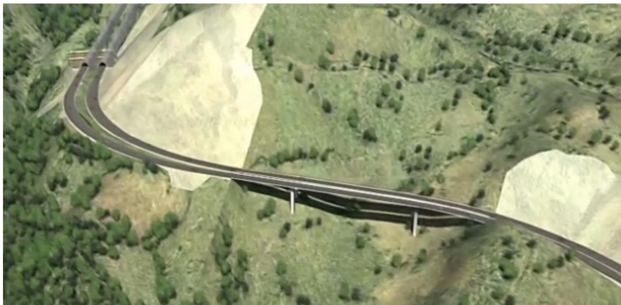
Figura 28. Vista conceptual del Viaducto El Trigo en el Portal Oriental del Túnel El Trigo entre el K12+200 y el K12+370 [301]. Esta ubicación se localiza dentro de la Reserva Nacional Natural San Francisco. El viaducto El Trigo tiene una longitud de 170 metros.
