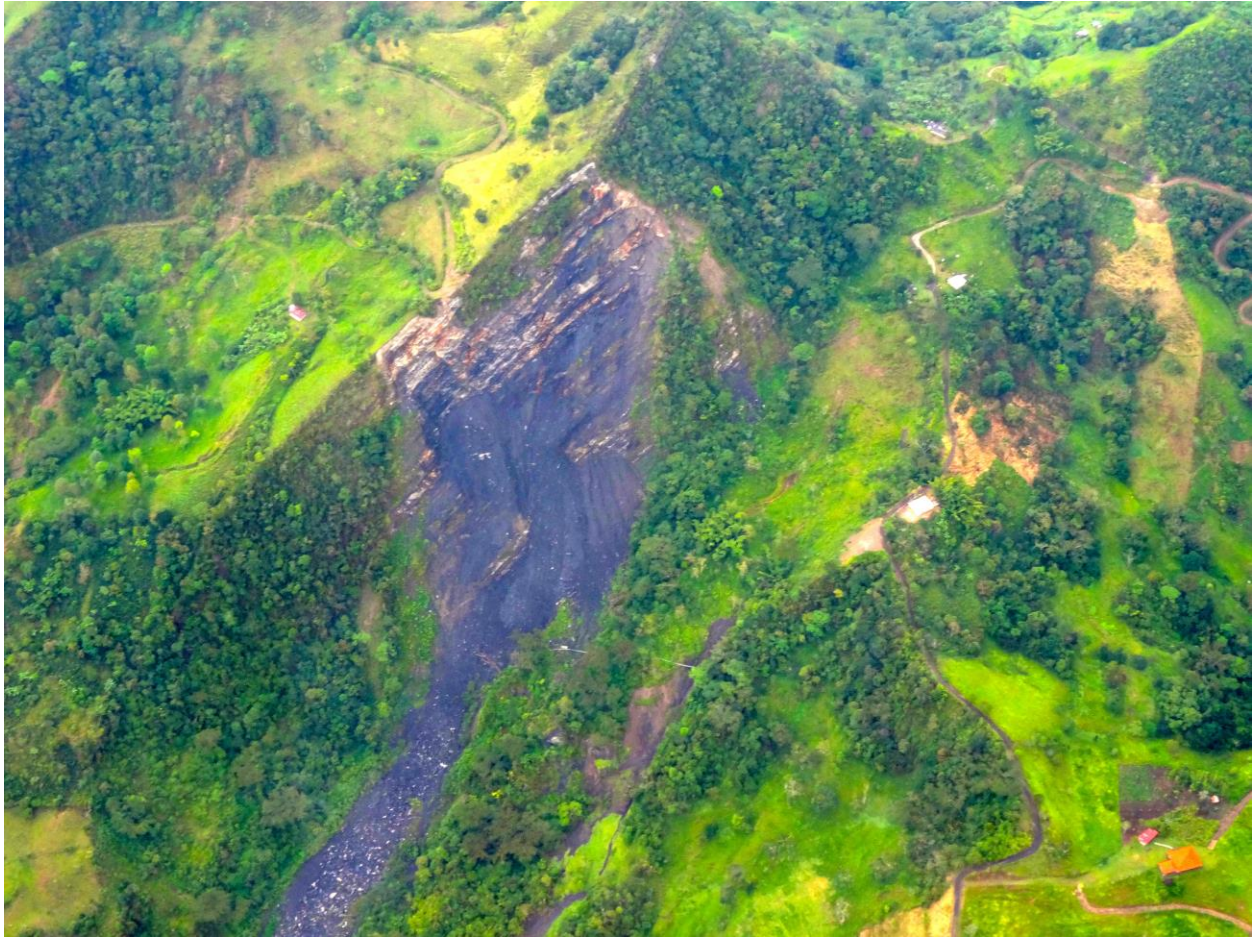
Figura 64. La imagen muestra una falla de talud con sedimentos negros de grano fino, con intercalaciones de material más competente hacia la parte más alta de la montaña. Esta imagen fue tomada en el vuelo de regreso a Bogotá, aproximadamente 4 kilómetros al suroccidente del Municipio de La Vega.
