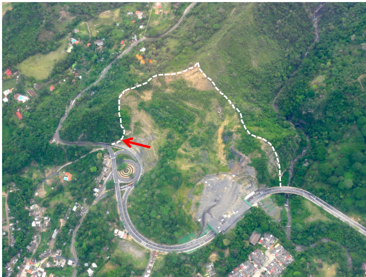
Figura 60. Mirando aproximadamente al noroccidente, el deslizamiento de El Cune – resaltado por la línea punteada blanca – es visible cerca del municipio de Villeta. La flecha roja muestra la ubicación aproximada de la Parada 1, cerca al K0+000. La Ruta 50 es visible en la parte inferior de la fotografía.
