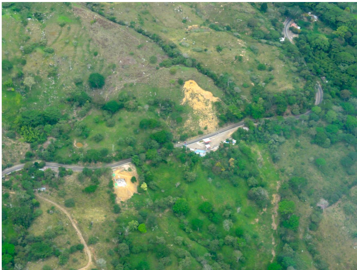
Figura 54. Esta imagen muestra la falla de en la ladera de una vía, aproximadamente al oriente de Honda y el Río Magdalena.
