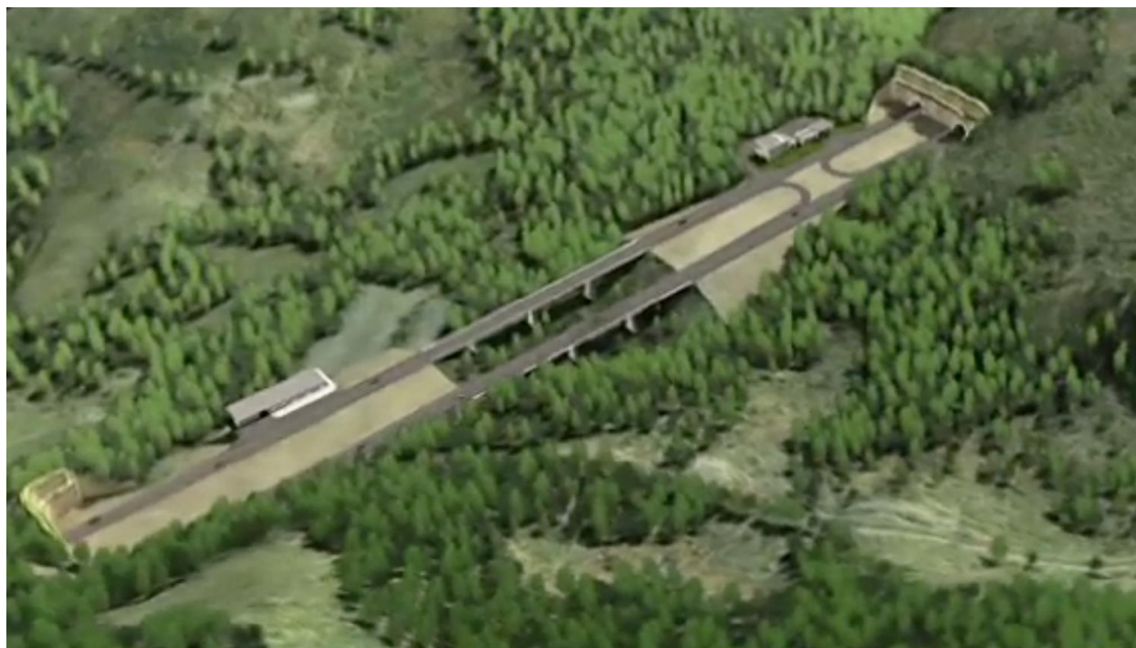
Figura 30. Vista conceptual del portal occidental del Túnel El Trigo (K14+630), un puente cruzando el valle sinclinal de la Falla del Alto del Trigo y el Río San Francisco. [301]. (Puente Río San Francisco Alto) y el portal oriental del Túnel La Cumbre (K15+140).
