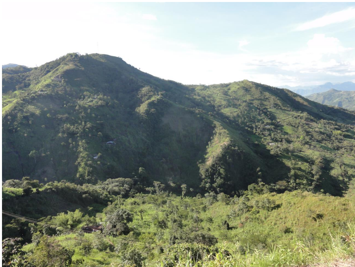
Figura 20. Mirando hacia el suroriente aproximadamente en el K4+000 cerca al Puente El Pencil (K4+110 al K4+260) a lo largo del trazado del Sector 1, Tramo 1 de la Ruta del Sol.
