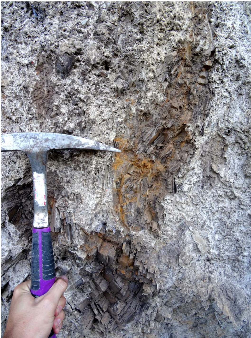
Figura 26. Lutitas deformadas en la zona de aproximadamente 1.5 a 2.0 metros de ancho, en el costado occidental del afloramiento de lutitas de la parada 11.
