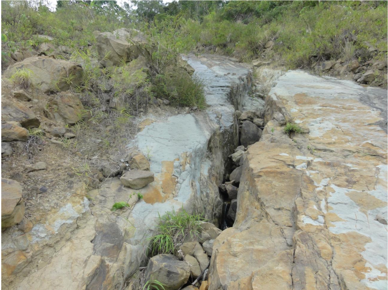
Figura 43. Una gran fractura por tensión en la misma capa de arenisca descrita en la Figura 37 sugiere que las capas de rocas sedimentarias mas competentes se están fracturando y separando entre sí. La fractura tiene aproximadamente 1 a 1.5m de ancho.
