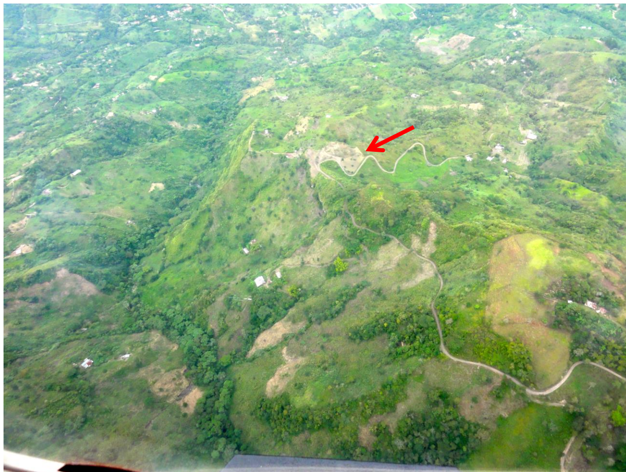
Figura 62. La flecha roja muestra la ubicación de la Parada 9. Al costado derecho de la fotografía, el trazado del Tramo 1 se dirige hacia la Reserva Nacional Natural San Francisco, antes de entrar al portal oriental del Túnel El Trigo.
