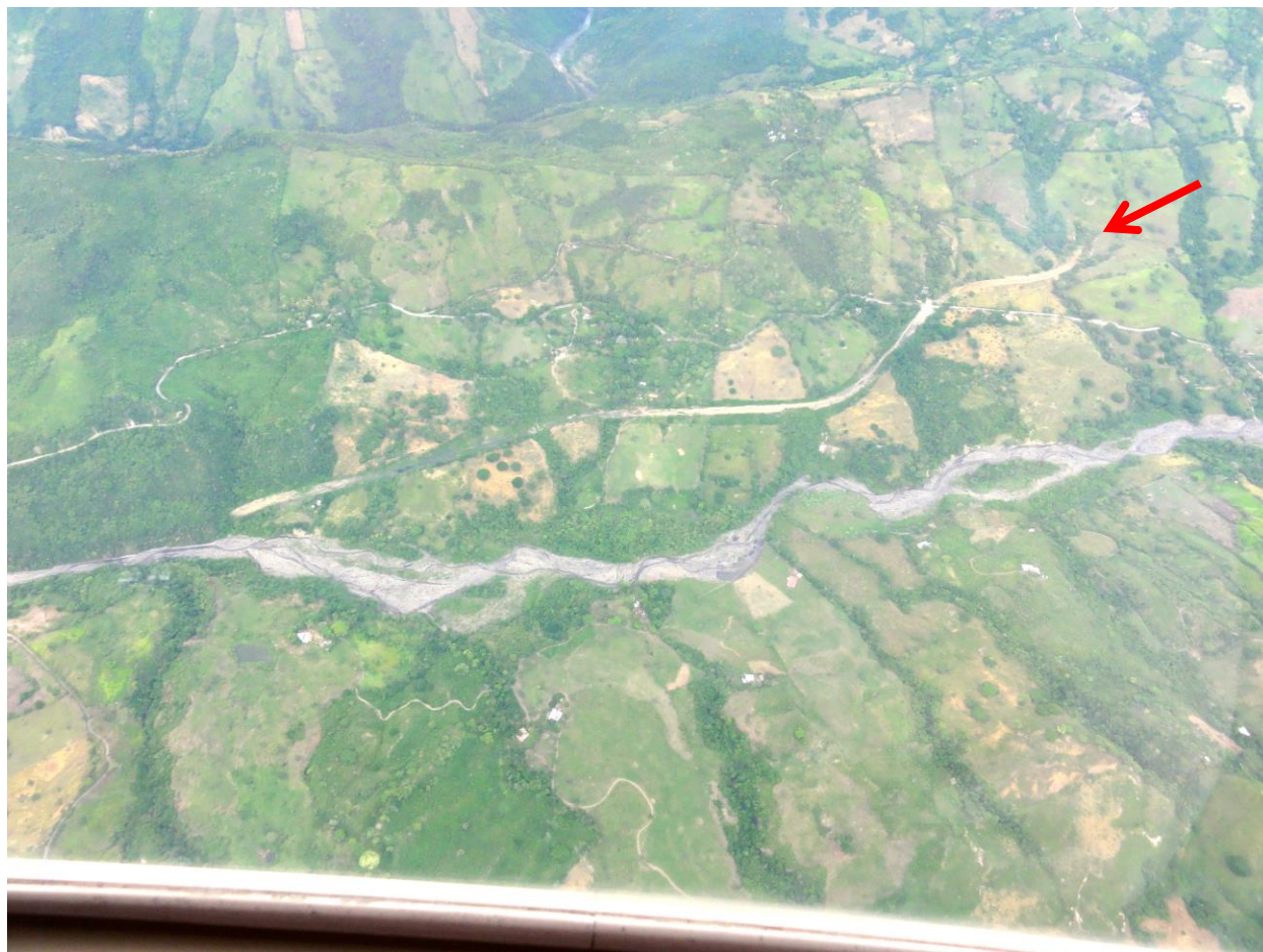
Figura 61. La imagen muestra una sección abandonada de Ruta del Sol cerca al municipio de Útica, la cual hace parte de un contrato previo que fue cancelado, no relacionado con el actual. La flecha roja muestra la ubicación del portal a un túnel que nunca fue construido. El trazado fue abandonado debido a las condiciones inestables del suelo.
