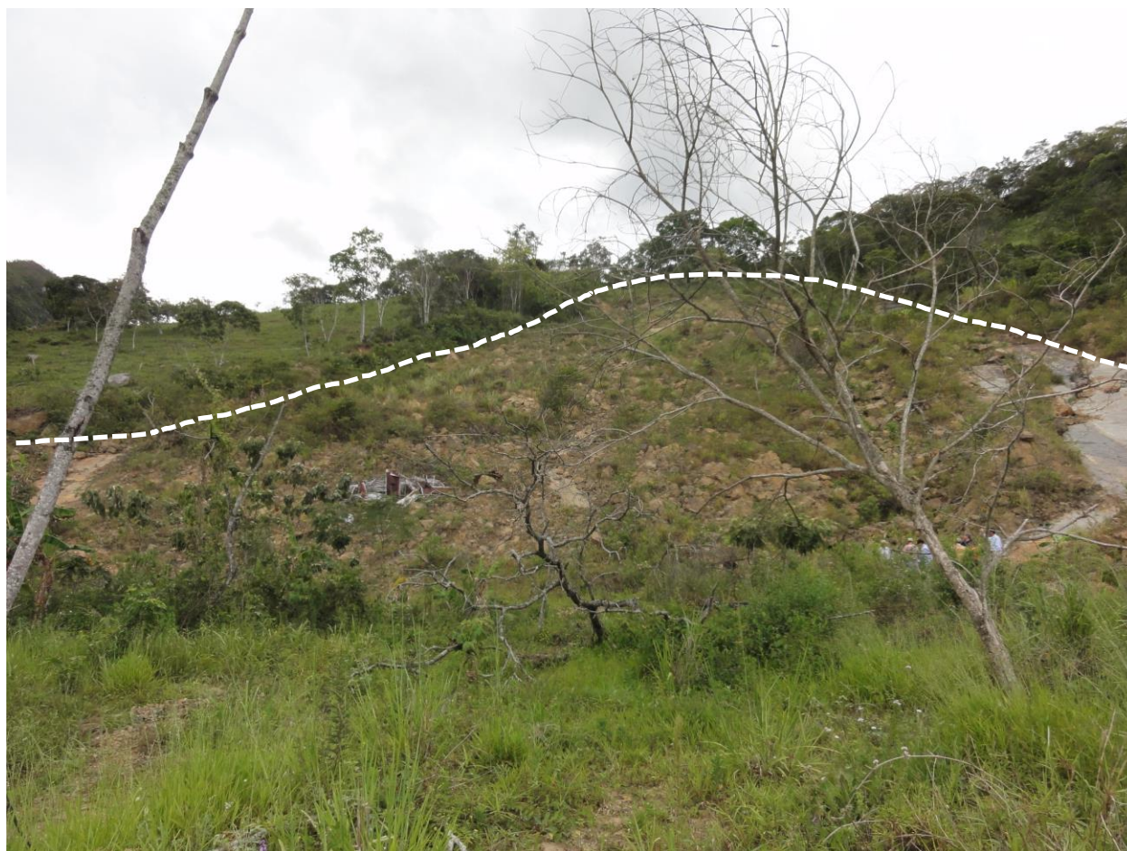
Figura 44. Escombros de sedimentos coluviales cerca a la parte superior del Deslizamiento de San Francisco.
