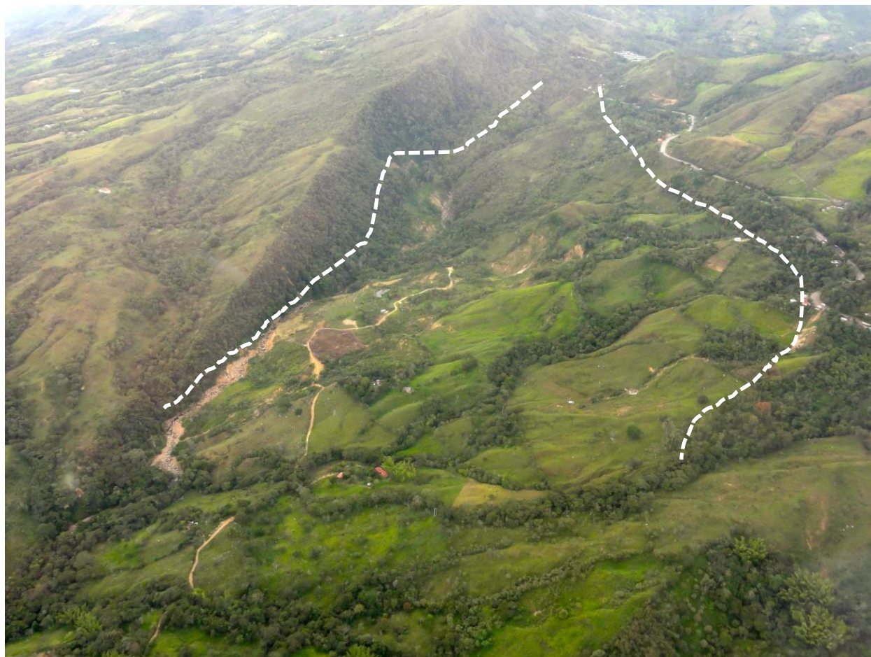
Figura 56. Justo al oriente de Guaduas, esta fotografía mira hacia el oriente al Deslizamiento de San Francisco, resaltado por la línea blanca punteada. Un corte alto está planeado en la montaña al lado izquierdo del deslizamiento (ver Parada 16). La Ruta 50 se encuentra al lado derecho del deslizamiento. La Falla La Magdalena con orientación oriente a occidente, cruza aproximadamente en el centro del Deslizamiento de San Francisco.
