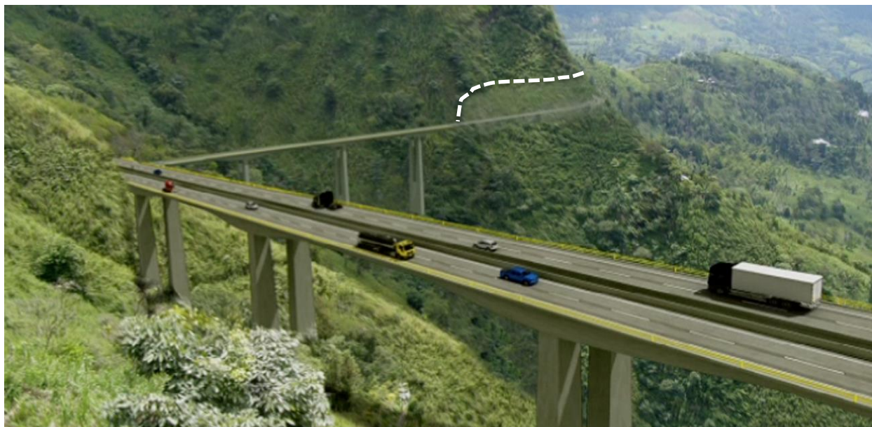
Figura 15. Vista conceptual del Viaducto Palermo (K8+500 al K9+290) [301]. Esta imagen presenta una vista al nororiente. Un corte de aproximadamente 17 metros de altura con una pendiente promedio de 2.5:1 (V:H) se resalta con la línea blanca puntuada aproximadamente en el K8+500.
