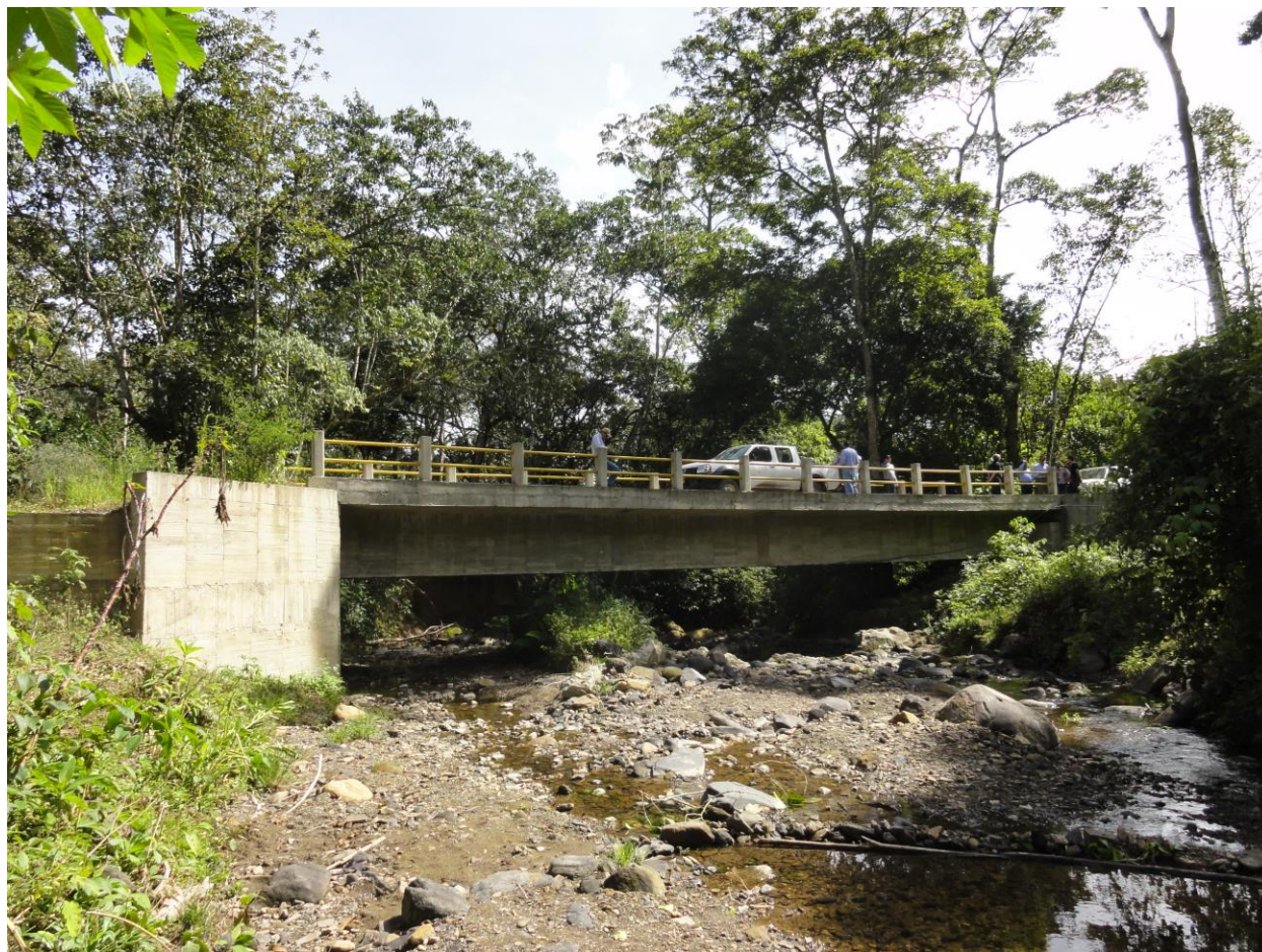
Figura 35. Vista hacia el norte; un puente nuevo en concreto sobre el Río San Francisco en la misma ubicación donde el puente original fue destruido durante el evento de La Niña 2010 – 2011. Continuando sobre el camino destapado hacia la izquierda de esta fotografía se llega a la Ruta Nacional 50.
