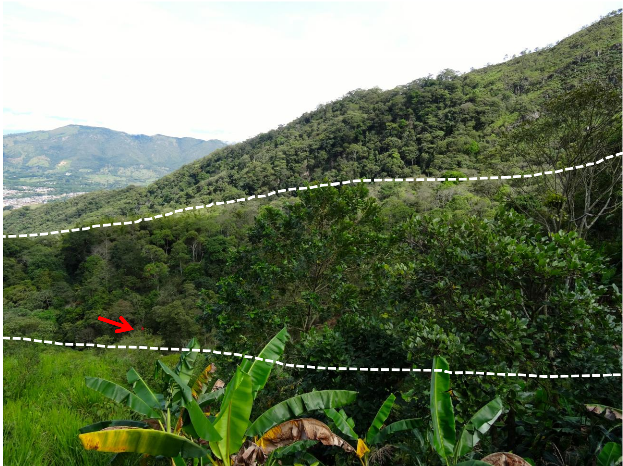
Figura 37. Tomada desde la Ruta 50, esta fotografía describe el Deslizamiento San Francisco, el cual está resaltado con la línea blanca punteada. La flecha roja muestra una banderilla que indica un punto en el trazado. Desde esta ubicación, se pueden ver árboles que crecen no verticales, característicos en los movimientos en masa. Un corte de 68 metros de altura está planeado en la ladera más lejana con una pendiente máxima de 2.3:1 (V:H). Esta foto presenta una vista hacia el noroccidente..
