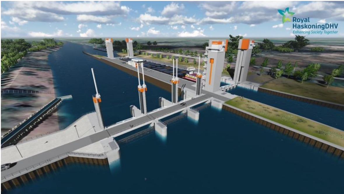
Figura 2-12 Compuerta de control activa en Calamar
