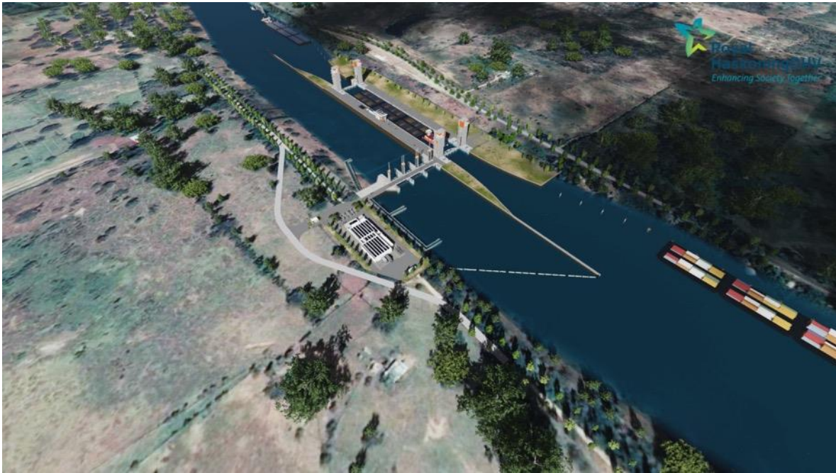
Figura 2-7 Complejo de compuertas de control y esclusa de Calamar
