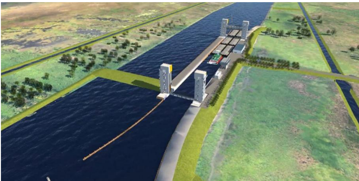
Figura 2-16 Complejo de compuertas de control y esclusa de Puerto Badel
