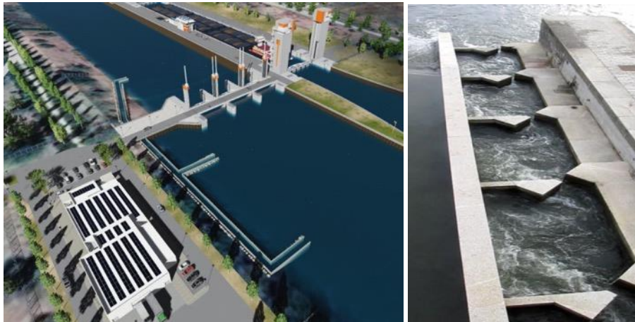
Figura 2-14. Ejemplo gráfico de un pase de ranura vertical con dos ranuras (D'Enno, et al, 2002) y plano paso de peces en Calamar
