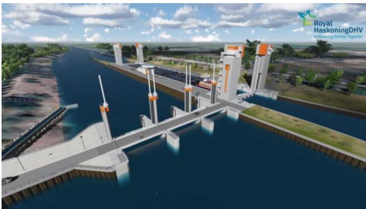
Figura 2-14 Compuerta de control activa en Calamar
