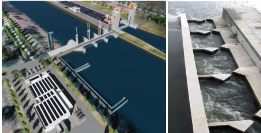
Figura 2-16. Ejemplo gráfico de un pase de ranura vertical con dos ranuras (D'Enno, et al, 2002) y plano paso de peces en Calamar
