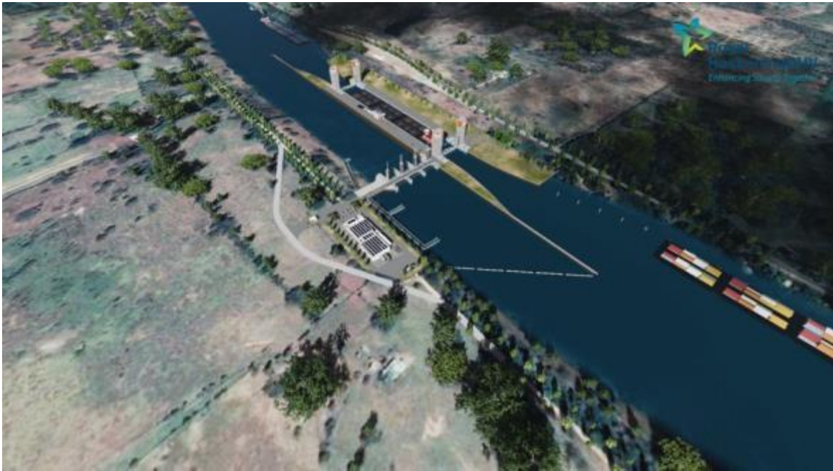
Figura 2-9 Complejo de compuertas de control y esclusa de Calamar
