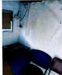
M4. Caseta de vigilancia interior
