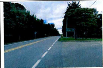
ENTORNO Y VÍA DE ACCESO
