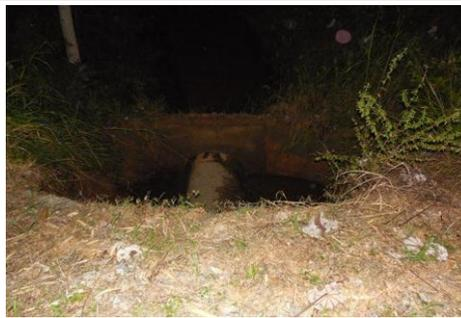
IMÁGENES DEL HUNDIMIENTO DEL TERRAPLEN FERROVIARIO POR DEFORMACIÓN DE LA SUBRASANTE PK 0436 + 364 EN EL SECTOR COMPRENDIDO ENTRE GRECIA - BARRANCABERMEJA
