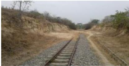
IMÁGENES DEL DESLIZAMIENTO DE TALUDES CON PASO DE FERROVÍA EN CORTE DE LADERA PK 598+605 AL 598+645 EN EL SECTOR COMPRENDIDO ENTRE RAMAL PUERTO CAPULCO
