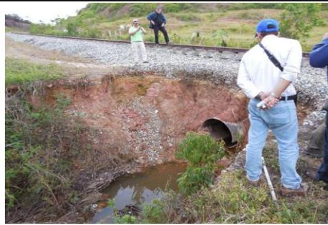
**IMÁGENES DEL HUNDIMIENTO DEL TERRAPLEN FERROVIARIO POR DEFORMACIÓN DE LA SUBRASANTE PK 0412 + 668 EN EL SECTOR COMPRENDIDO ENTRE GRECIA - BARRANCABERMEJA**
