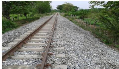
IMÁGENES DEL HUNDIMIENTO DEL TERRAPLÉN FERROVIARIO POR DEFORMACIÓN DE LA SUBRASANTE PK 0421 + 100 EN EL SECTOR COMPRENDIDO ENTRE GRECIA - BARRANCABERMEJA
