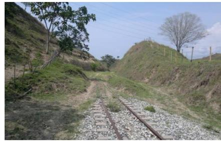
IMÁGENES DEL DESPLAZAMIENTO DE TALUDES CON PASO DE FERROVÍA EN CORTE DE LADERA PK 296+645 AL 296+710 EN EL SECTOR COMPRENDIDO ENTRE RAMAL NARE
