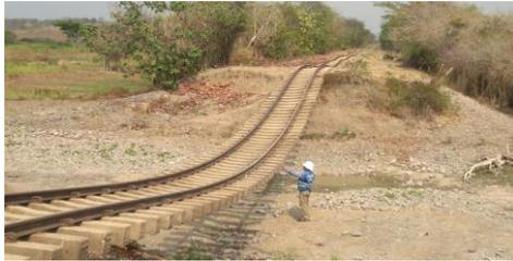
IMÁGENES DEL HUNDIMIENTO DEL TERRAPLÉN FERROVIARIO POR DEFORMACIÓN DE LA SUBRASANTE PK 600+960 AL 601+010 EN EL SECTOR COMPRENDIDO ENTRE RAMAL PUERTO CAPULCO
