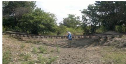
IMÁGENES DEL HUNDIMIENTO DEL TERRAPLÉN FERROVIARIO POR DEFORMACIÓN DE LA SUBRASANTE PK 602+100 AL 602+130 EN EL SECTOR COMPRENDIDO ENTRE RAMAL PUERTO CAPULCO
