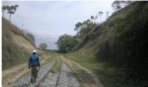
IMÁGENES DEL DESIZAMIENTO DE TALUDES CON PASO DE FERROVÍA EN CORTE DE LADERA PK 296+430 AL 296+570 EN EL SECTOR COMPRENDIDO ENTRE RAMAL NARE
