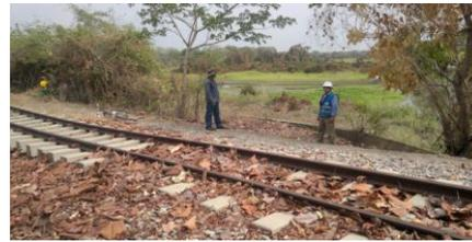
IMÁGENES DEL HUNDIMIENTO DEL TERRAPLÉN FERROVIARIO POR DEFORMACIÓN DE LA SUBRASANTE PK 601+246 AL 601+276 EN EL SECTOR COMPRENDIDO ENTRE RAMAL PUERTO CAPULCO
