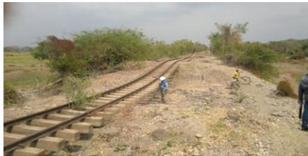
IMÁGENES DEL HUNDIMIENTO DEL TERRAPLÉN FERROVIARIO POR DEFORMACIÓN DE LA SUBRASANTE PK 601+050 AL 601+100 EN EL SECTOR COMPRENDIDO ENTRE RAMAL PUERTO CAPULCO
