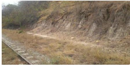
IMÁGENES DEL DESLIZAMIENTO DE TALUDES CON PASO DE FERROVÍA EN CORTE DE LADERA PK 600+280 AL 600+350 EN EL SECTOR COMPRENDIDO ENTRE RAMAL PUERTO CAPULCO
