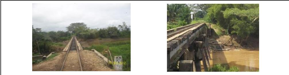
IMÁGENES DE LA SOCAVACIÓN DE ESTRIBOS EN PUENTES PK 0423 + 895 EN EL SECTOR COMPRENDIDO ENTRE GRECIA-CABAÑAS
