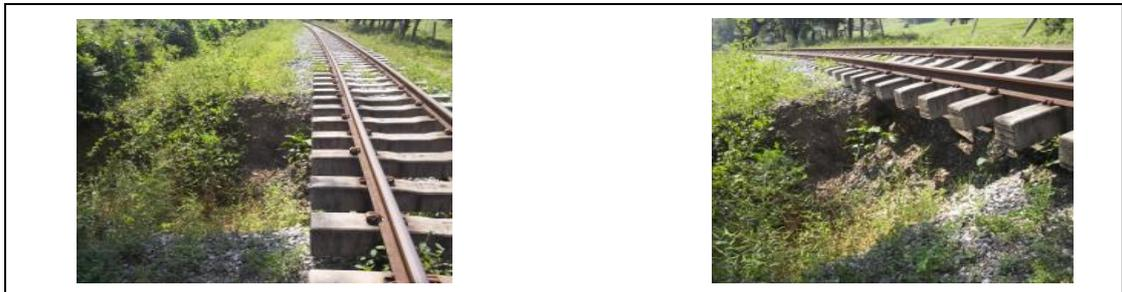
IMÁGENES DEL HUNDIMIENTO DEL TERRAPLÉN FERROVIARIO POR DEFORMACIÓN DE LA SUBRASANTE PK 0235 + 540 EN EL SECTOR COMPRENDIDO ENTRE LA DORADA-PUERTO TRIUNFO
