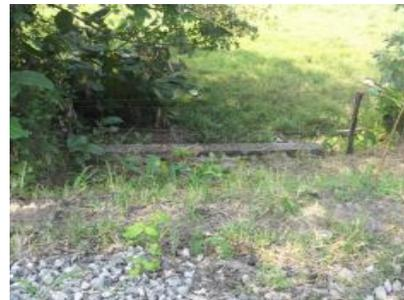
IMÁGENES DEL HUNDIMIENTO DEL TERRAPLEN FERROVIARIO POR DEFORMACIÓN DE LA SUBRASANTE PK 0230 + 600 EN EL SECTOR COMPRENDIDO ENTRE LA DORADA-PUERTO TRIUNFO
