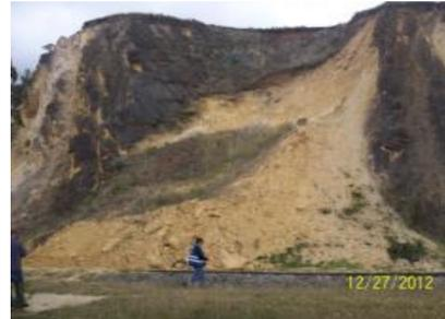
IMÁGENES DEL DESLIZAMIENTO DE TALUD CON TERRAPLÉN FERROVIARIO A PIE DE LADERA PK 0123 + 200 EN EL SECTOR COMPRENDIDO ENTRE ALBARRACÍN-VENTAQUEMADA
