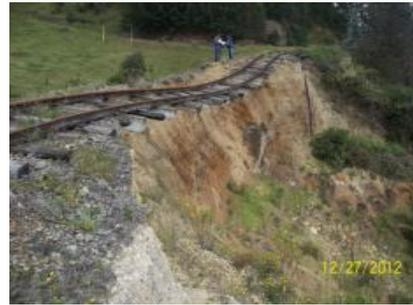
**IMÁGENES DEL DESPLAZAMIENTO DE TALUD CON TERRAPLÉN FERROVIARIO A PIE DE LADERA PK 0126 + 200 EN EL SECTOR COMPRENDIDO ENTRE ALBARRACÍN-VENTAQUEMADA**
