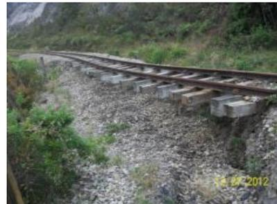
**IMÁGENES DEL DESLIZAMIENTO DE TALUD CON TERRAPLÉN FERROVIARIO A PIE DE LADERA PK 0129 + 900 EN EL SECTOR COMPRENDIDO ENTRE ALBARRACÍN-VENTAQUEMADA**
