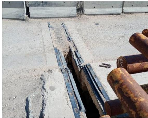
6. Foto Puente sobre el río Balsillas, UF1. Presenta deterioro de las juntas elastómeras costado norte.
