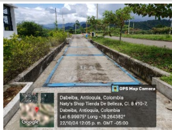
Foto 43. Estación de pesaje de Mutatá.
