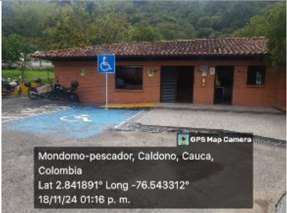
Foto 29. Infraestructura operación Ovejas (PR49+050).
