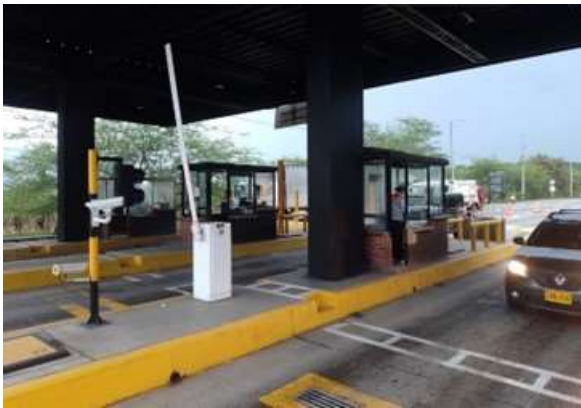
Foto 39. Equipos e infraestructura peaje Cerrito.
