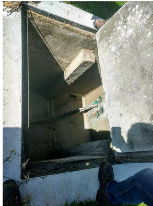
Foto 6. Caja de inspección de redes eléctricas con cableado.
