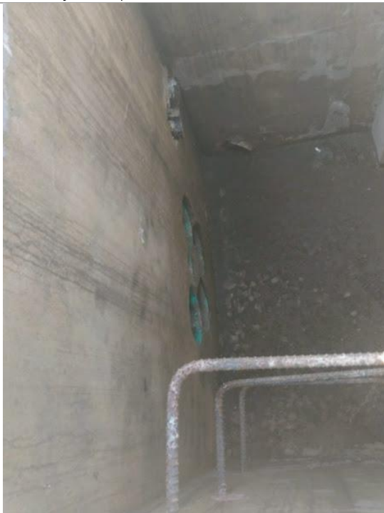
Foto 5. Caja de inspección de redes eléctricas sin cableado.
