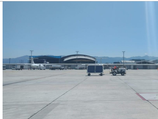
Foto 14. Hangares de Avianca fase II.
