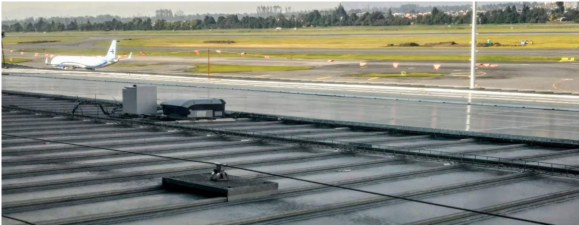
Foto 15. Sistema de autogeneración fotovoltaico.
