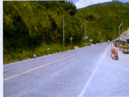
Foto 8. Infraestructura existente PK2+300
