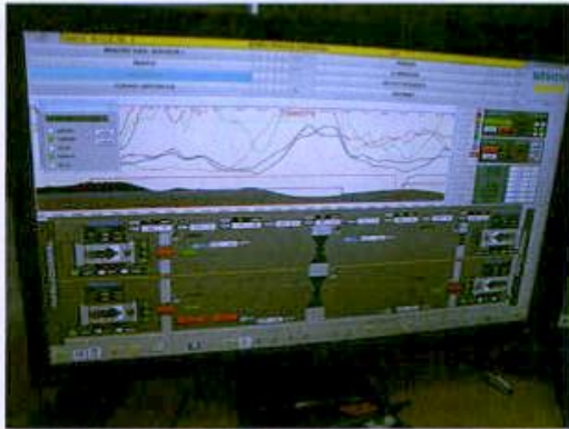
Foto 65. Equipos sala de control túnel de Occidente
