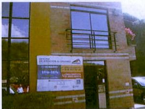
Foto 67. CCO Túnel de Occidente.
