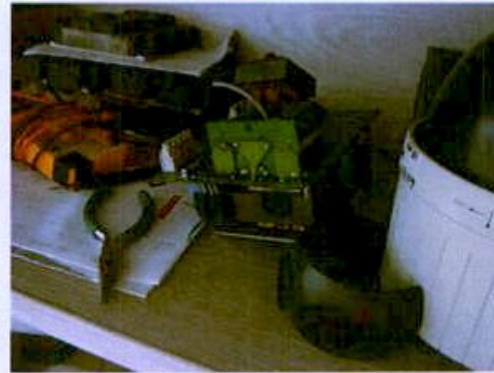
Foto 66. Equipos sala de control túnel de Occidente
