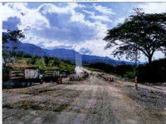
En el inicio de la UF2 se evidenció el inicio de señalización de obra, estabilización de taludes, excavación y retiro de material de excavación.
