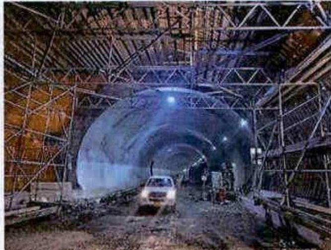
En la calzada derecha (tubo 1) se observaron trabajos de revestimiento en bahías de parqueo e impermeabilización en galerías de conexión, de acuerdo con los reportes de la Interventoría.
