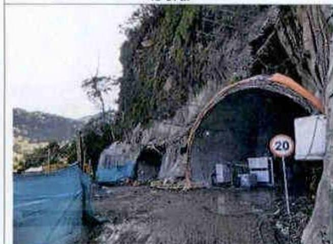
Foto 16. Portal de salida de la calzada izquierda y avance de la conexión con el Puente Mulatos de la UF3.
