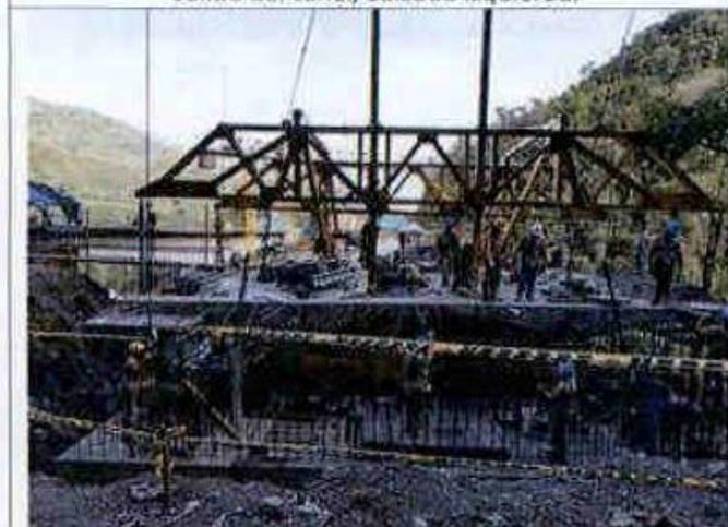
Foto 18. Estabilización del portal de entrada, calzada derecha.
