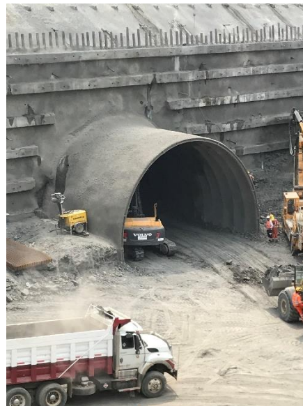
Foto 24. Portal de entrada Túnel la Sorda UF7
