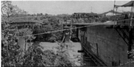
Avance en el proceso constructivo del puente el cual tuvo varios ajustes en el diseño mientras adelantaba su construcción. La interventoría no viene haciendo seguimiento al mismo por no tener el diseño final.
