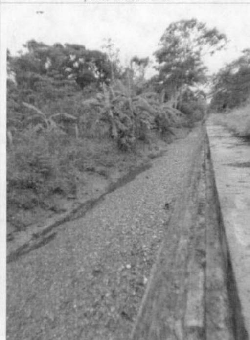
**Foto 2.** Estructura de drenaje tipo Box culvert del punto crítico 1.
