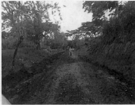
Foto 3. Intervenciones de conformación de banca.
