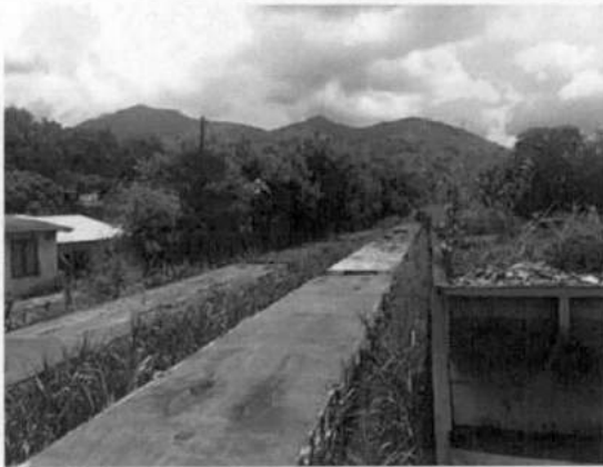
Foto 19. Plataformas y tolvas balasteras.
