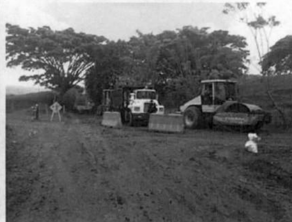
Foto 4. Equipos de obra dispuestos por TDO en actividades de conformación de banca.
