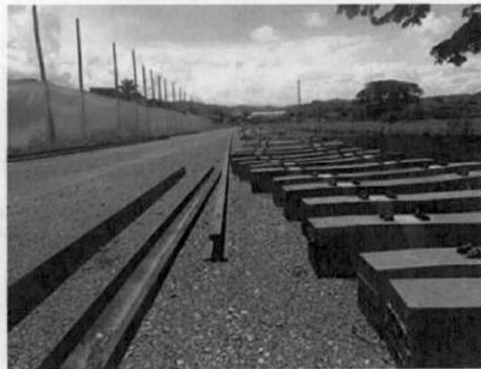
Foto 10. Detalle de insumos para la instalación de vía férrea.
