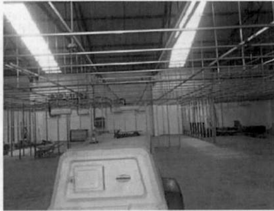
Foto 13. Intervenciones al interior del edificio de la estación del ferrocarril en Cali.
