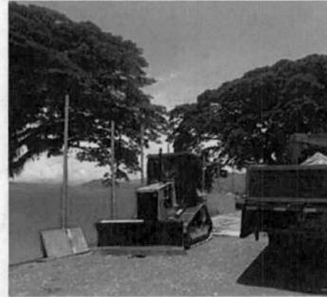
Foto 8. Equipos de construcción para la preparación del terreno.
