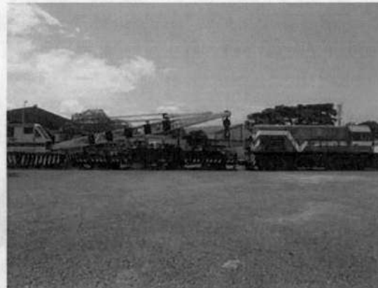
Foto 18. Equipo de construcción y mantenimiento de vía férrea en la estación de Yumbo.
