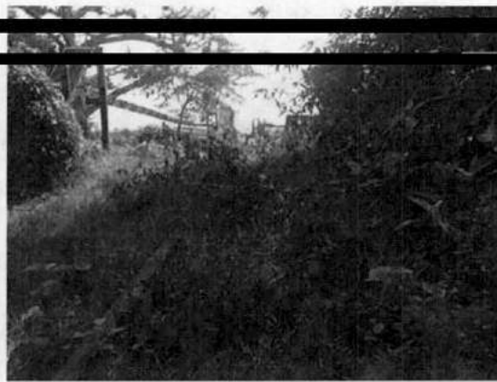
Foto 24. Vía férrea obstruida por la vegetación en un extremo del puente El Bolo.
