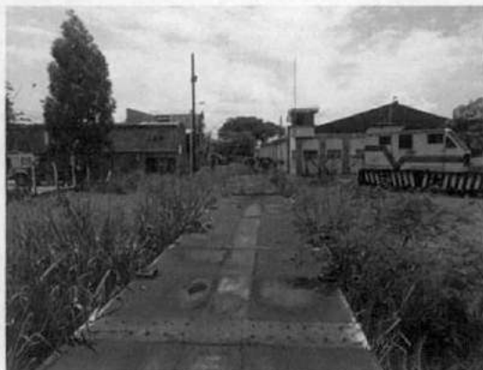
Foto 17. Plataformas estacionadas sobre la vía férrea en la estación de Yumbo.
