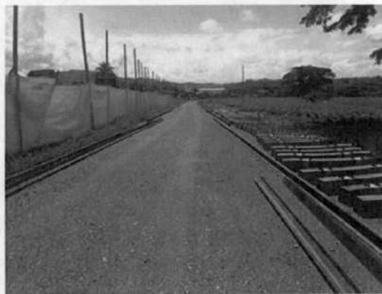
Foto 9. Traviesas, perfiles de carrilera y rieles dispuestos para iniciar actividades de instalación de vía férrea.
