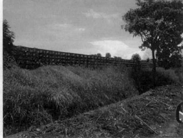
Foto 12. Acopio de traviesas de concreto.
