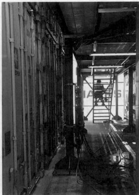
Foto 4. Detalle de instalación de tableros de conexión en los equipos racks para conexión de contenedores
