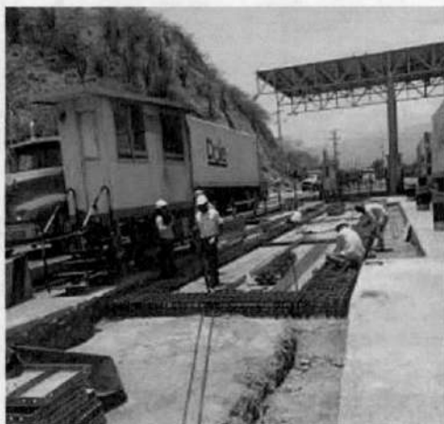
Foto 11. Construcción de nueva báscula de pesaje para vehículos.
