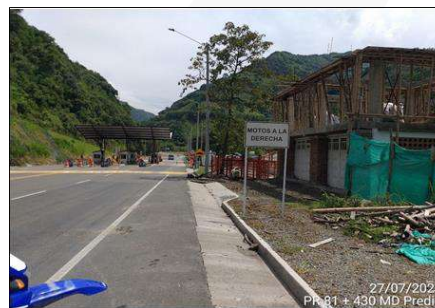
Foto 132. CP3-UF5-CMSCN-038- Margen Derecha
