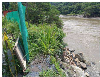
Foto 129. CP3-UF5-CMSCN-038- Margen Derecha
