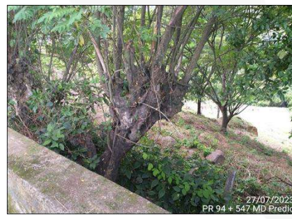
Foto 144. CP3-UF5-CMSCN-059- Margen Derecha
