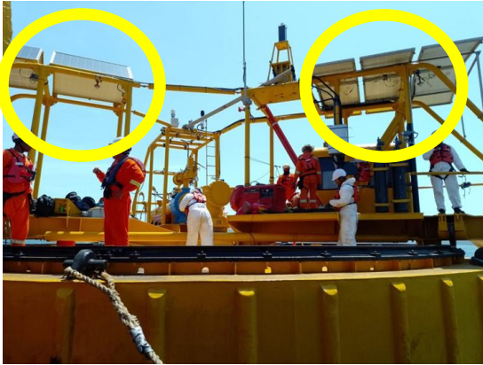
Foto 7. Paneles solares monoboja Valeria.
