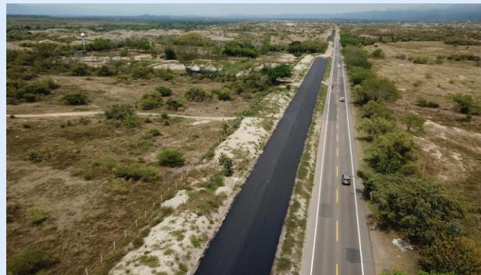
Foto No. 2 Segunda calzada pavimentada en primera capa. UF 2
