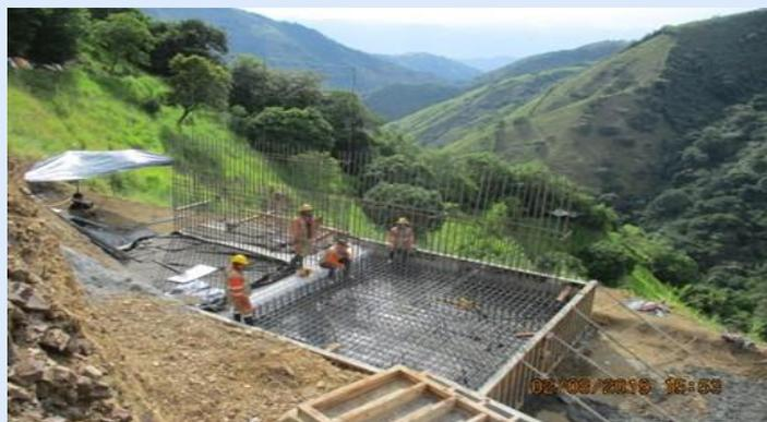
U.F.1: PK9+790 Muro en HA. Personal hace el alistamiento para proceder a la fundida 'con concreto hidráulico' de la zapata del muro, modulo 5.
