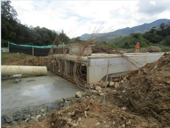
Foto No. 1 Construcción Box Couvert UF-2
