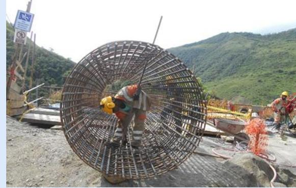
K1+200 UF2: Armada de canasta de refuerzo para pilas de puente 1
