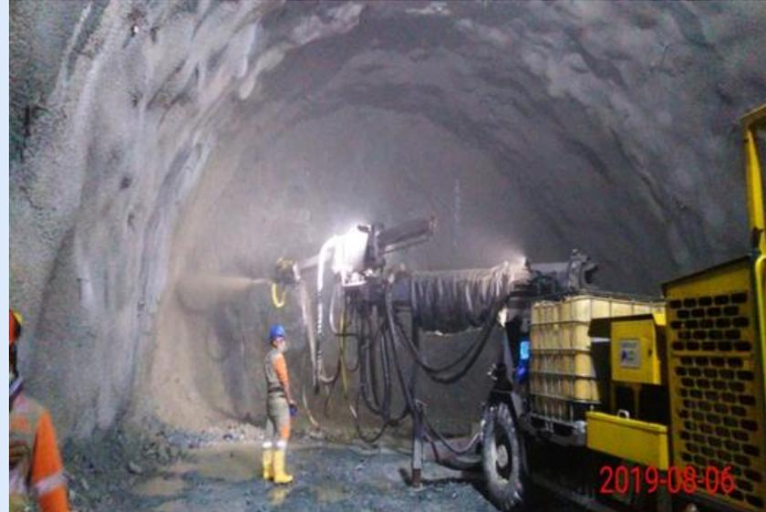
Foto No. 2: UF 2 K5+460 (Portal de Salida - Túnel de Tesalia). Excavación Bóveda, tipo de soporte B-2.
