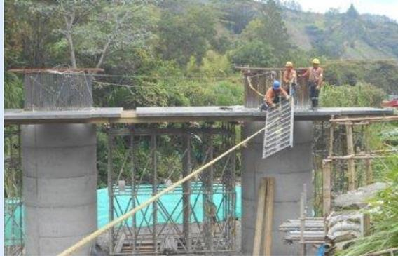
Superficie para construcción de viga cabezal del apoyo 2, Puente 1.
