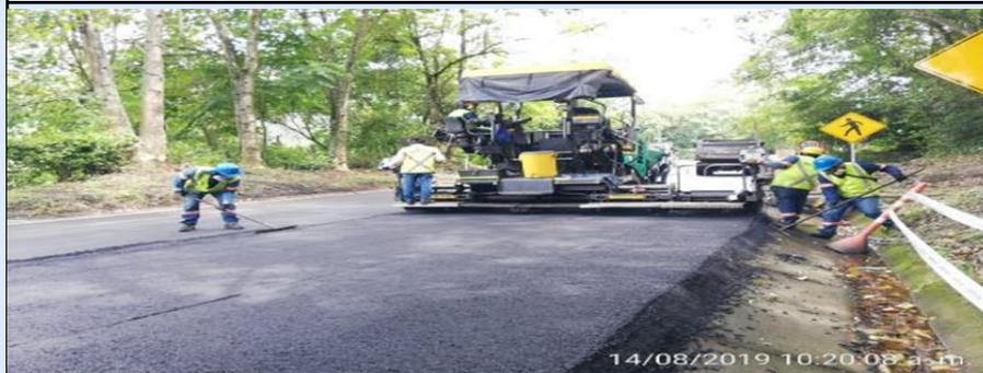
Instalación de Asfalto (MDC-19), en el PR 109+660. Margen derecho de la vía sentido Pamplona - Cúcuta.
