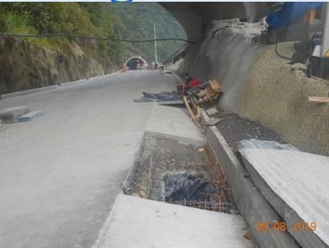
UF1: Se observa una de las cajas de inspección de la red de tubería canalizada, para la alimentación de energía.
