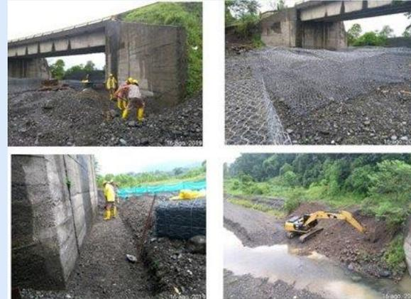
K8+900 Construcción de muros en gaviones en el puente Surrabay 2 UF5
