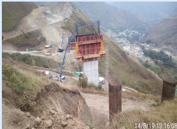
**UF 3. K38+576 - K38+801. Construcción Puente el Porvenir. Armado de acero de d6vcla sobre cimbra pila**
