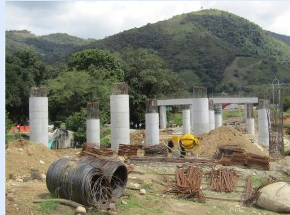
Foto No. 2 Construcción de Pilas de Puentes UF-2
