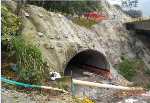
Túnel 2 - Portal Bogotá. Se realiza la construcción de dados de anclajes y su tensionamiento respectivo.
