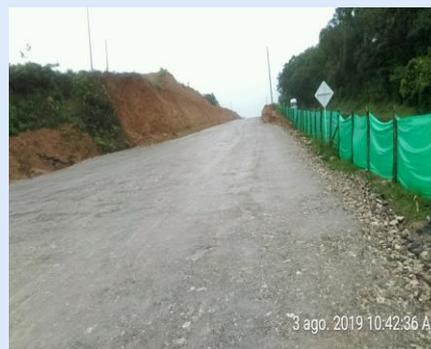
UF Instalacion de material tolerante a 3" para la construccion de la Estructura "terraplen" via nueva calzada .MD.
