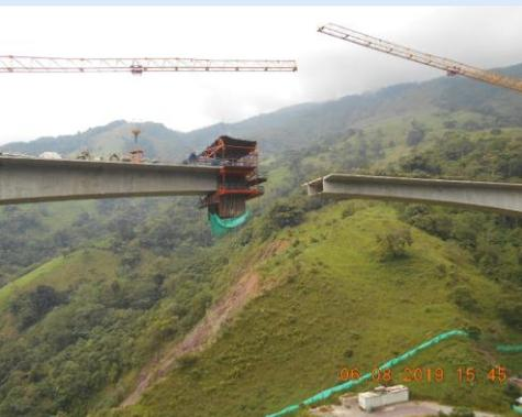
UF 4: Punte 7 viaducto Pipiral eje 4 y 5, panorámica. Fundieron barreras de tráfico, andenes e instalaron barandas metálicas.
