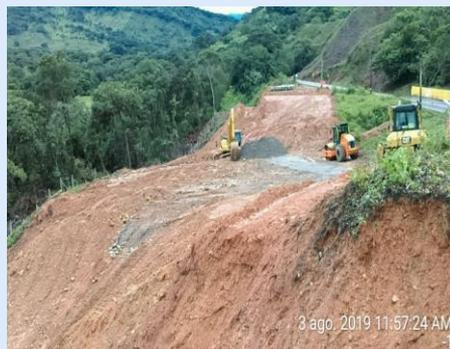
UF 6. descapote y cajeo para la instalacion y compactacion de material para construccion de pedraplen MD, para ampliacion de la via.
