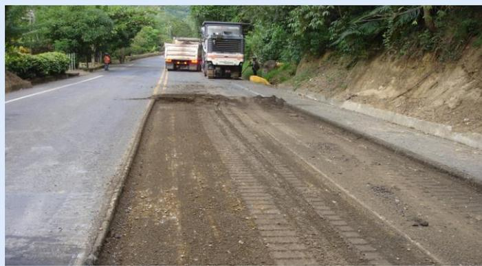
U.F.4: PK 12+900: Fresado en frío de un área fallada. La fresadora Wirtgen W-150 ha cortado la caja hasta una profundidad de 10 cms.
