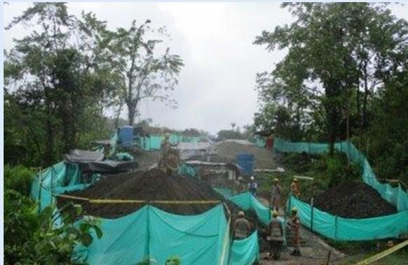
PK23+273 Excavación y anillado pilotes Puente 11 UF4
