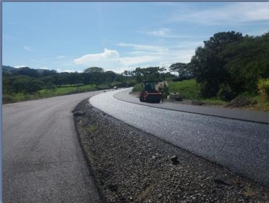
Foto No. 1 UF2. Km 22+200, Colocación base asfáltica.
