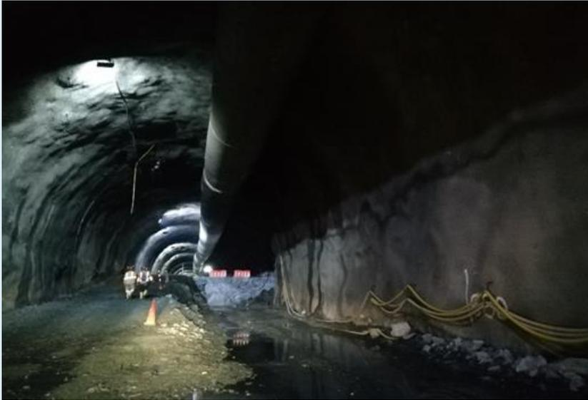
Foto No. 1: UF 2 K5+654,70 (Portal de Entrada - Túnel de Tesalia). Avance mecánico sobre terreno brechoso en contacto con granito en zona de falla.
