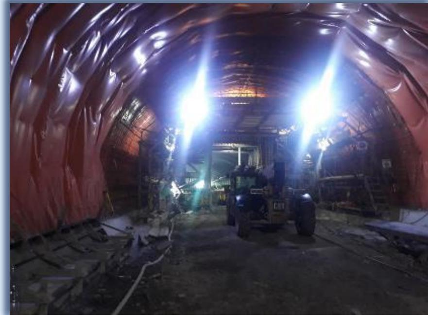
Foto No. 2 UF3. Túnel Mulatos. Calzada derecha: Impermeabilización y revestimiento entre K34+077.
