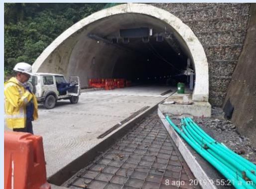
Túnel 6 portal Bogotá, pavimento en concreto hidráulico.
