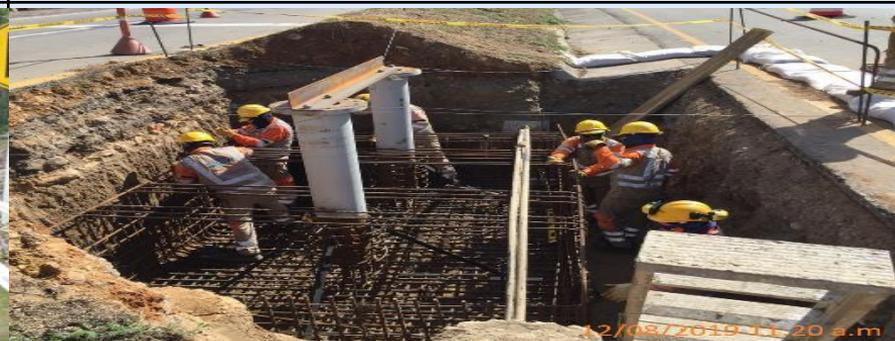
Instalación de acero de refuerzo para la pila 4 del Puente peatonal la Garita PR124+000
