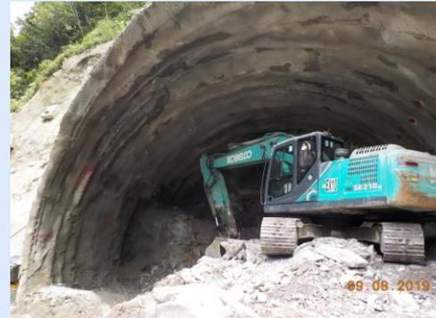
Túnel 3 - Frente PV. continúa la excavación subterránea terreno tipo V.
