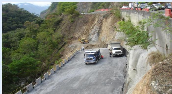
U.F.2: PK22+950: Muro en TA. Se ejecuta excavación mecánica y cargue de material para dar alarque al muro, hacia el PK menor.
