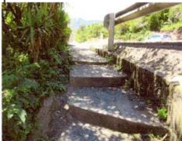
ESCALERAS EN CONCRETO
