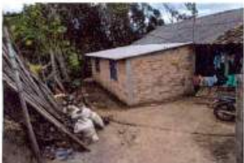
C4 CONSTRUCCION OBRA NEGRA
