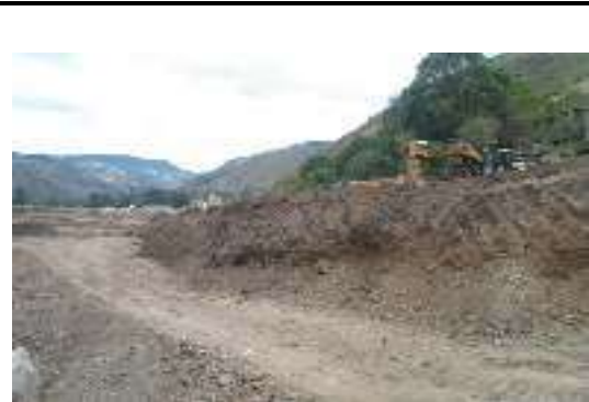
LOCALIZACION DEL SECTOR - VISTA SUR
