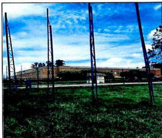
VISTA DEL ÁREA REQUERIDA, M8 PARALES EN CERCHA METÁLICA
