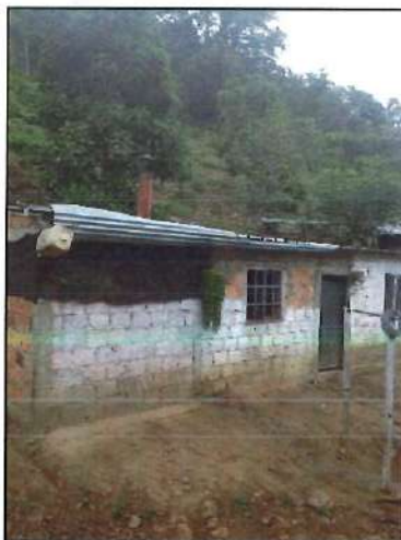
FACHADA CONSTRUCCIÓN C1M1.
