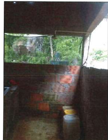
ALBERCA CONSTRUCCIÓN C1M1.
