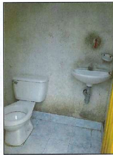
INTERIOR CONSTRUCCIÓN C4M1.
