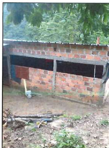
FACHADA CONSTRUCCIÓN C1M1.
