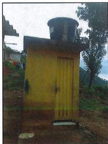
FACHADA CONSTRUCCIÓN C4M1.
