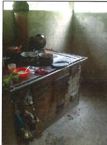
COCINA LEÑA CONSTRUCCIÓN C1M1.
