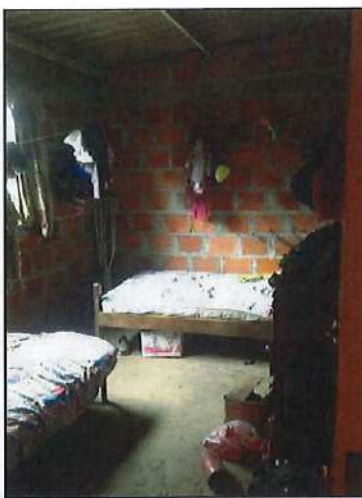
INTERIOR CONSTRUCCIÓN C2M1.
