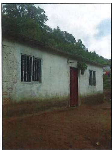
FACHADA CONSTRUCCIÓN C2M1.
