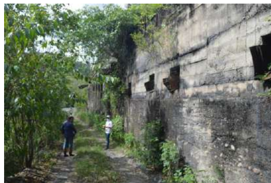
CA10 MUROS DE PANTALLA
