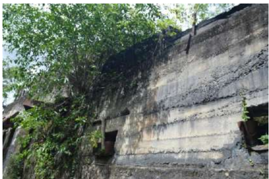
CA10 MUROS DE PANTALLA
