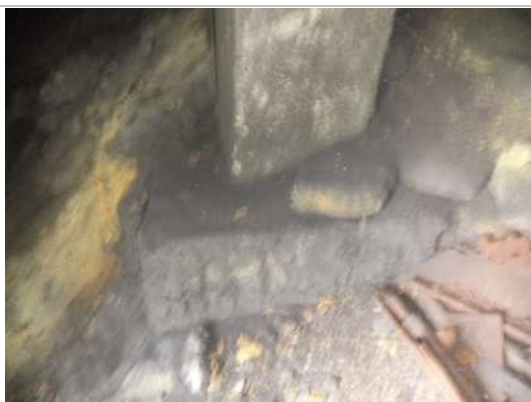
CA10 ZAPATAS Y COLUMNAS (SON 15)
