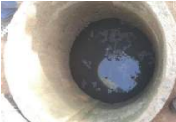
Vista Interna Pozos
