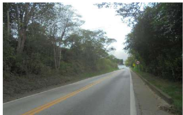
Vía de Acceso sobre la Via Nacional
