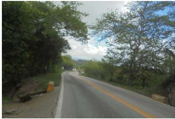
Vía de Acceso sobre la Via Nacional
