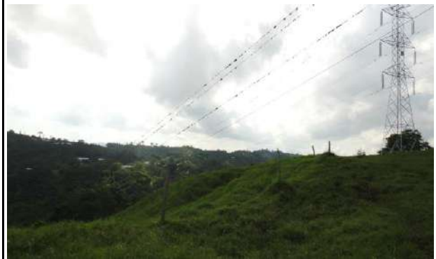
B2: Cerca perimetral
