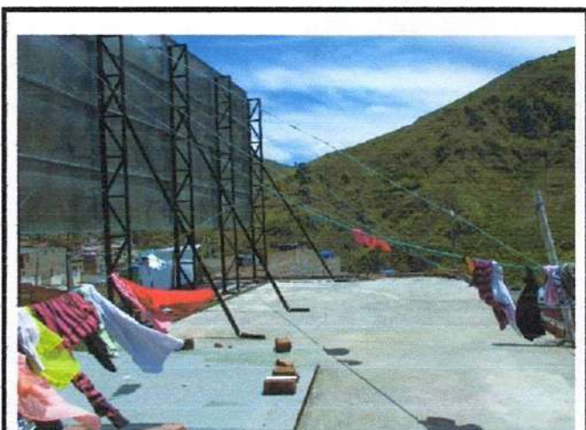
TERRAZA Y ESTRUCTURA METALICA
