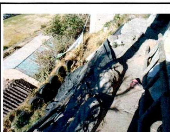
A3 MURO DE CONTENCIÓN
