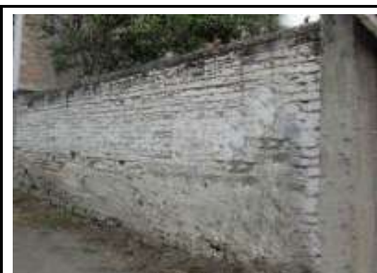
A1 MURO DE CERRAMIENTO
