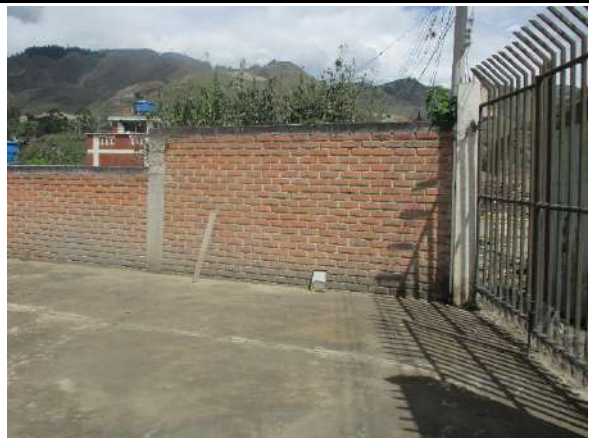
A8 PORTON, A9 ZONA DURA Y A12 MURO 4
